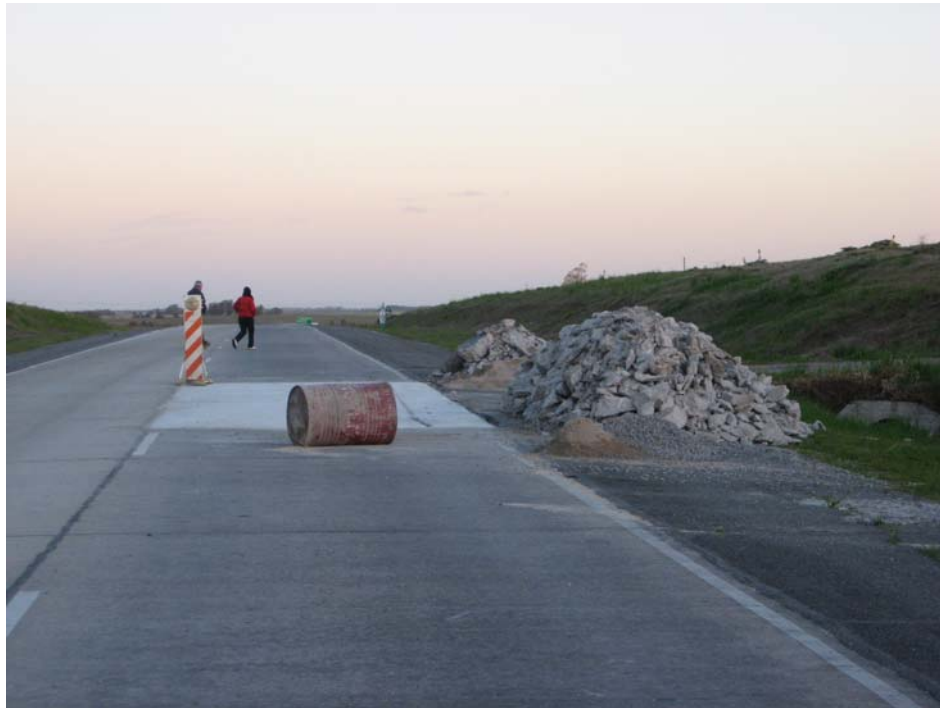
Tareas de reconstrucción de pavimento de hormigón
