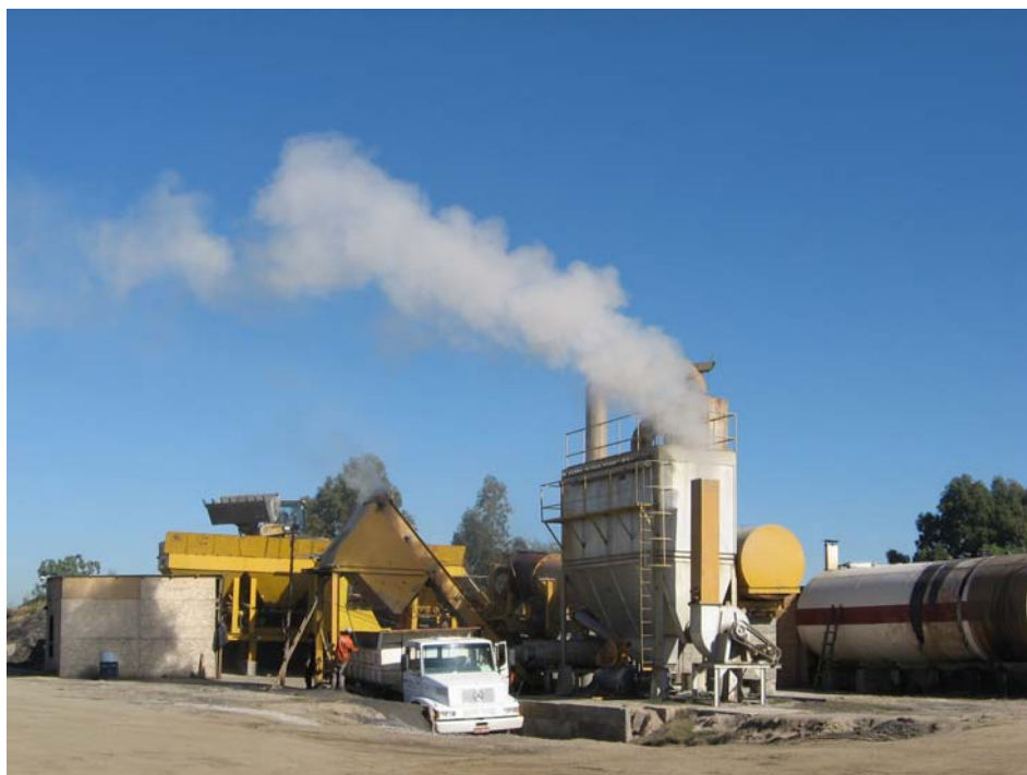
Vista de la planta de mezcla asfáltica de la firma Molinsur
