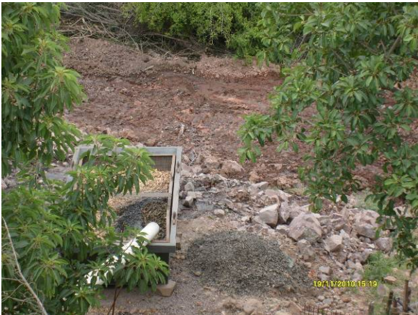
Ilustración 11 – Sedimentador asociado a planta asfáltica
