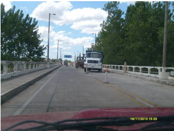
Ilustración 7 – Frente de obra sobre puente Centenario
