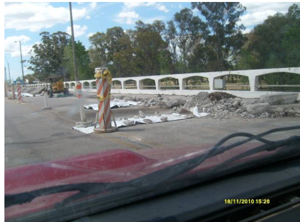
Ilustración 8 – Frente de obra sobre puente Centenario
