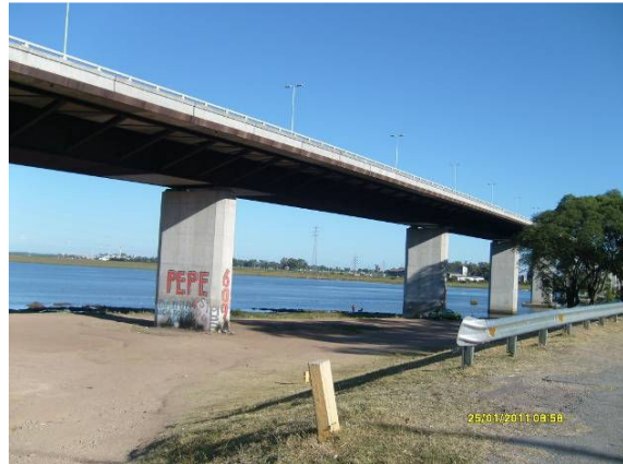
Ilustración 6 – Puente nuevo sobre el río Santa Lucía sin signos de erosión en cabeceras ni pilares
