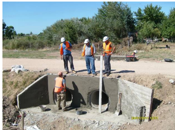
Ilustración 8 – Construcción de alcantarilla
