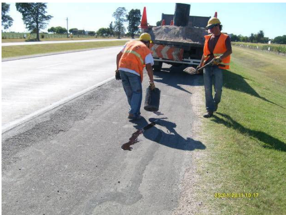
Ilustración 7 – Sellado de fisuras en banquetas
