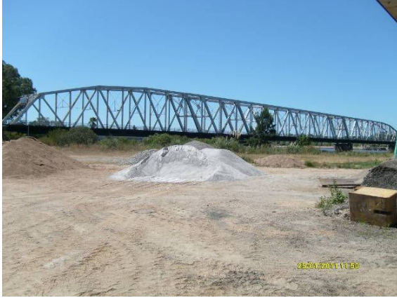
Ilustración 3 – Obrador, acopios, planicie aluvial y río Santa Lucía
