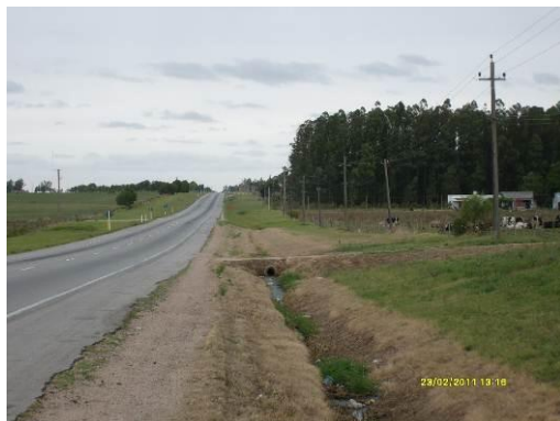
Ilustración 12: Herbicida en cunetas
