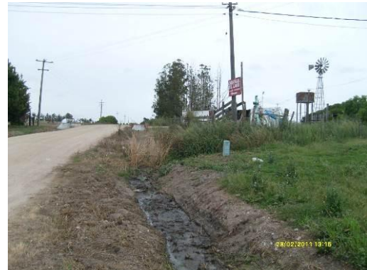
Ilustración 11 –Herbicida en cunetas
