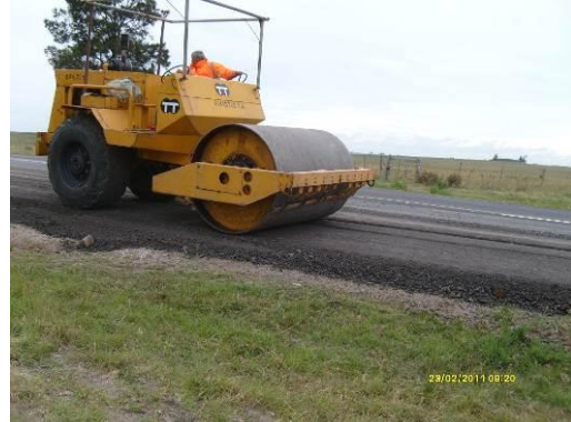
Ilustración 5 – Compactación de RAP en banquetas
