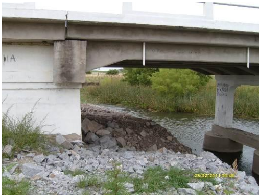
Ilustración 6: Protección del puente con enrocado
