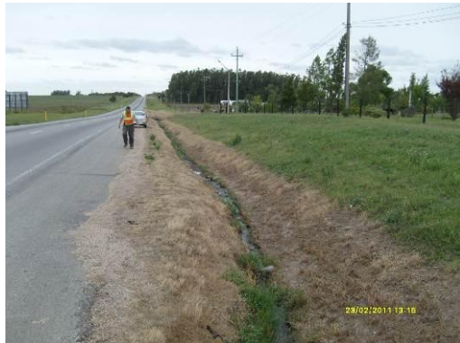
Ilustración 10 – Herbicida en cunetas
