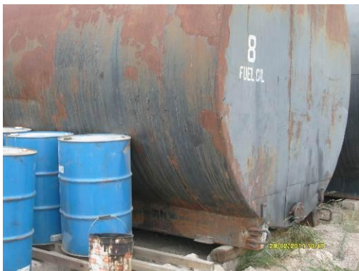
Ilustración 8: Depósito de fueloil y tambores de gasoil sin contención de derrames
