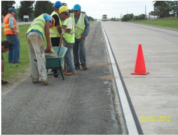
Ilustración 9: Frente de obra, sellado de fisuras y juntas
