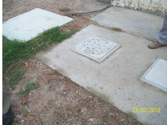
Ilustración 4: Obrador -nuevo pozo negro
