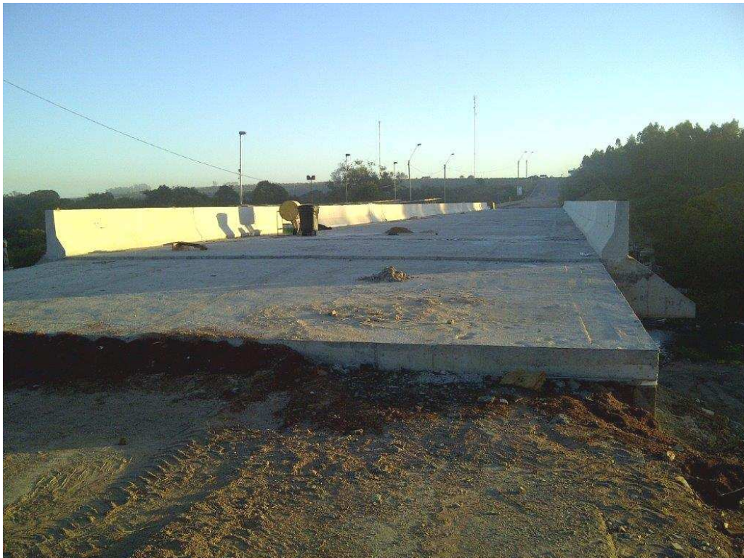
Figuras 2 a 7: Diferentes vistas de la obra
