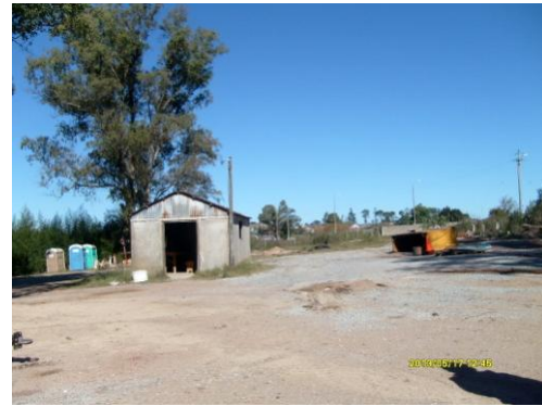
Ilustración 6: Obrador con instalaciones originales y limpieza del terreno
