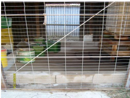
Ilustración 7: Zona de almacenamiento de combustibles y sustancias peligrosas con barreras de contención
