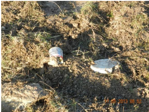
Ilustración 5: Residuos aparecidos en zona del obrador luego de la nivelación
