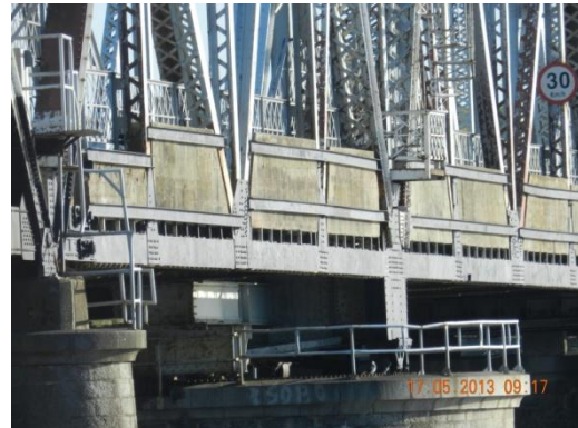
Ilustración 7: Barandas para mantener en su lugar a los contrapesos de la vereda en parte móvil del puente
