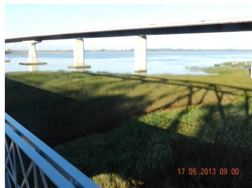
Ilustración 8: Parte de los humedales próximos al puente viejo y al nuevo, y a donde estuvo el obrador
