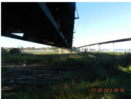
Ilustración 6: Zona debajo del puente en margen derecha
