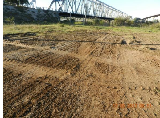
Ilustración 4: Zona donde estuvo el obrador luego de la nivelación
