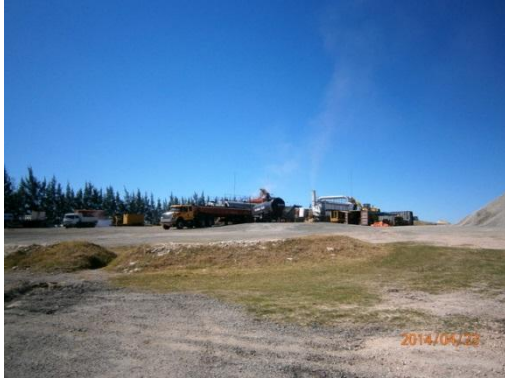
Ilustración 4-Obrador trabajando. Al fondo cortina de árboles.
