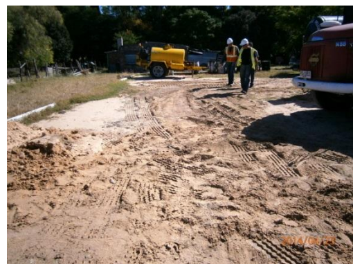
Ilustración 9-Area acondicionada para lavar y humedecer caja de camiones
