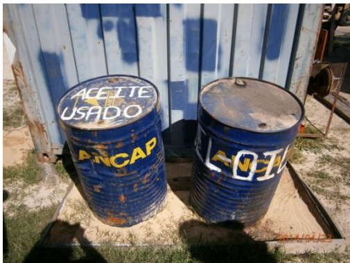
Ilustración 6-Sistema de almacenamiento y contención de aceite usado
