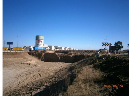
Ilustración 6 - Frente de obra en Ruta 1 y Cno. Tomkinson
