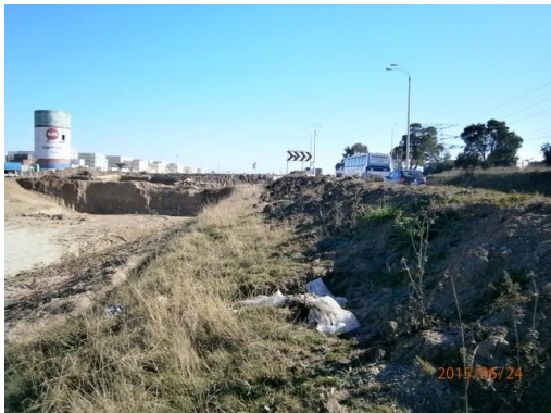
Ilustración 7 - Frente de obra en Ruta 1 y Cno. Tomkinson
