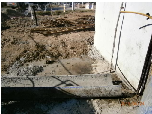
Ilustración 9 - Obrador MOLINSUR, área de lavado
