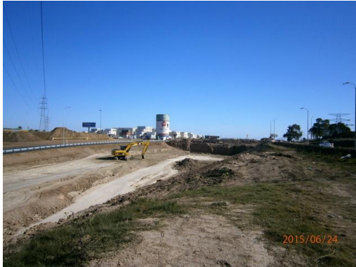
Ilustración 5 - Frente de obra en Ruta 1 y Cno. Tomkinson
