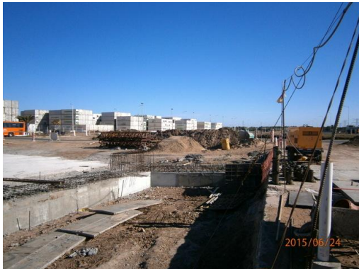
Ilustración 11 - Obrador SACEEM sobre Cno. Tomkinson
