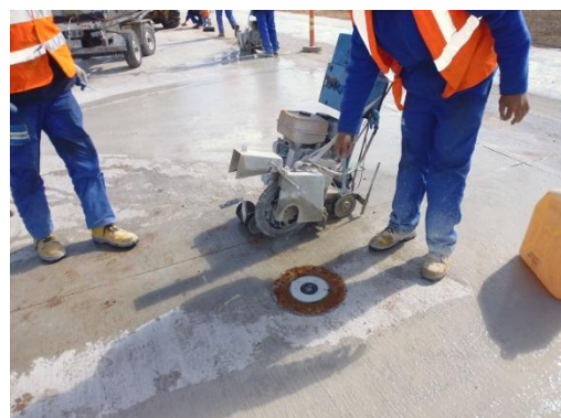
Ilustración 19 – Frente de obra.
