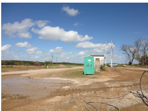
Ilustración 18 – Baños químicos junto a la planta de hormigón.
