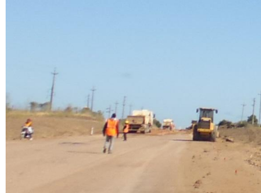
Ilustración 9 – Frente de obra.
