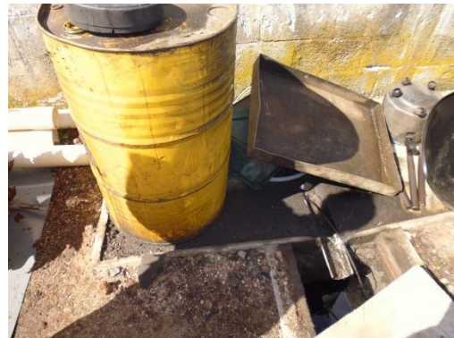
Ilustración 17 – Zona de acopio de residuos especiales. Se recuerda que todos los residuos deberán estar sobre sistema de contención para posibles fugas.
