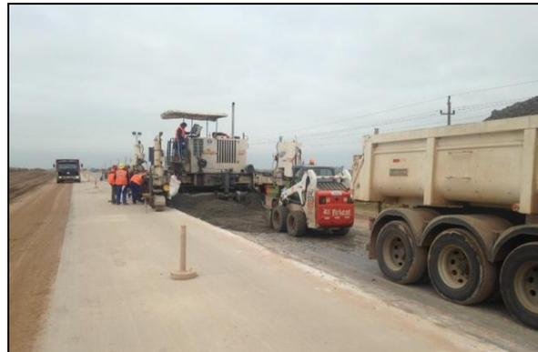
*Extendido del hormigón en la segunda senda pavimentada (julio 2015).*
