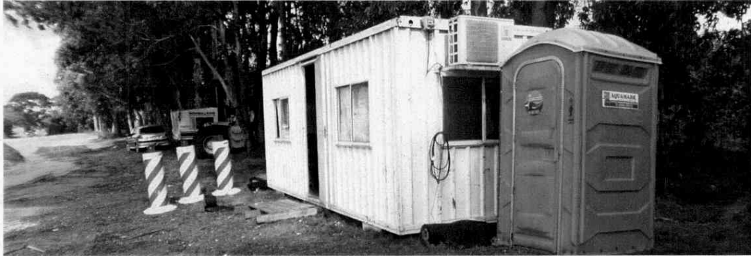
Gráfico 2-2 Trabajos realizados por cuadrilla de TECHINT
