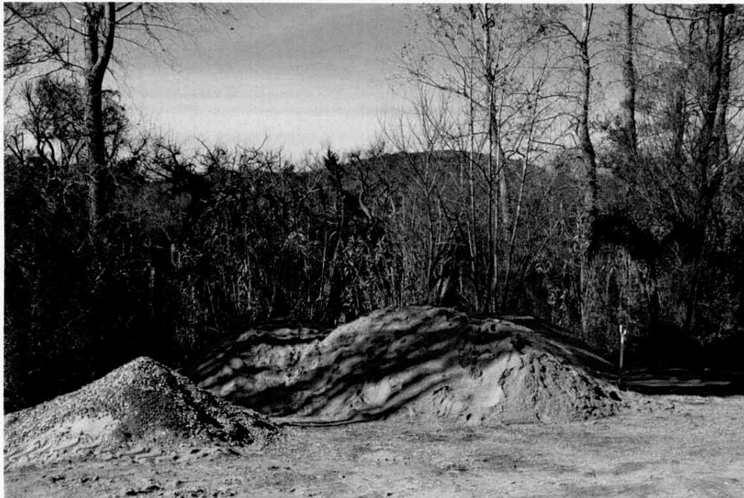
Figura 3-1 Acopio de áridos en el Obrador
