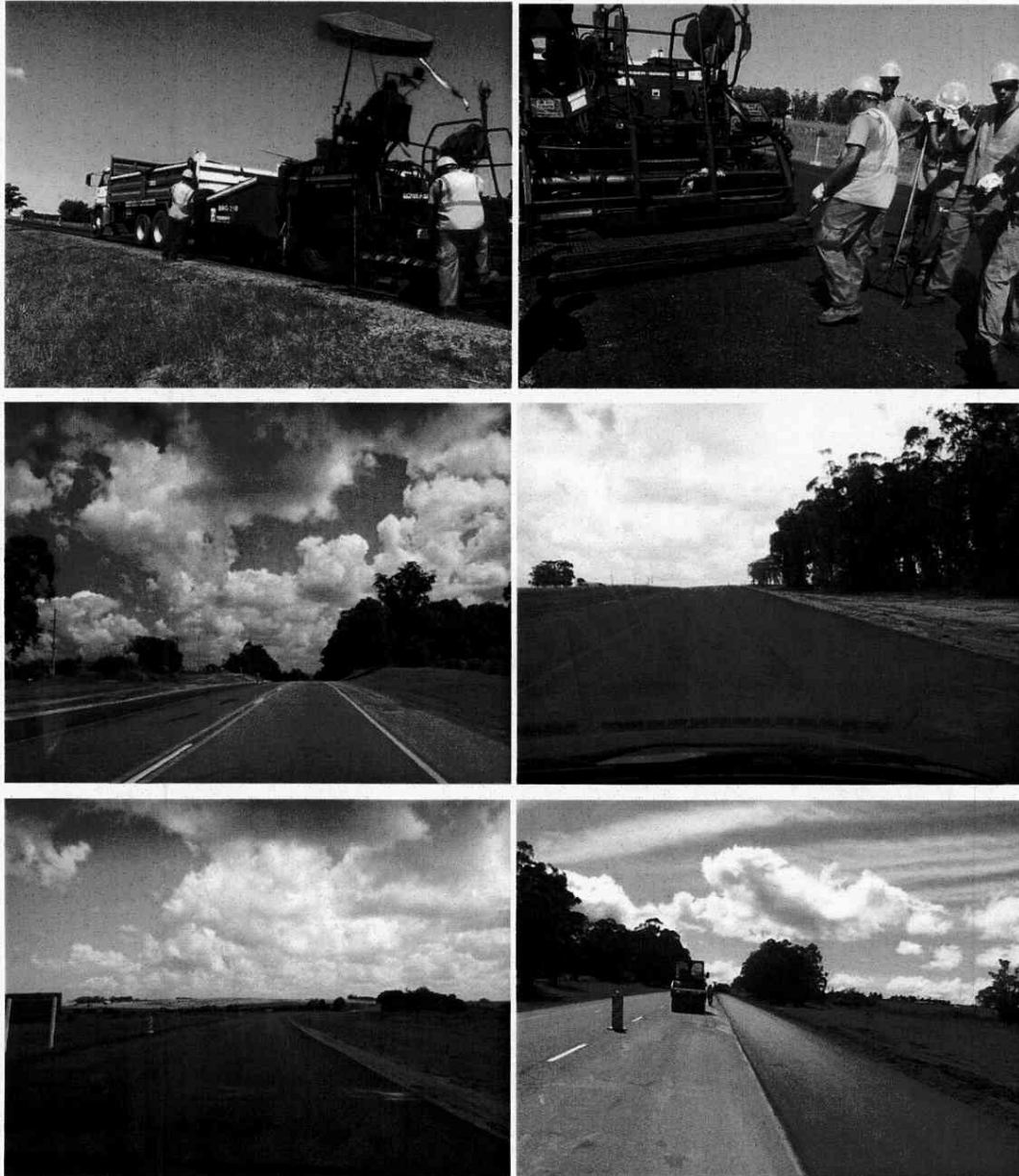
Gráfico 2-1 Trabajos realizados por cuadrilla de TECHINT
