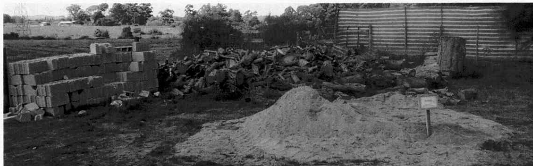
Gráfico 3-2 Acopio de áridos en obrador PIETROBONI
