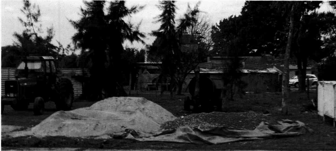
Figura 3-2 Acopio de áridos en obrador PIETROBONI
