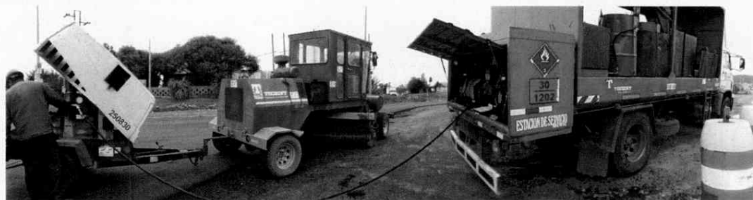
Figura 3-1 Camión surtidos trabajando en los frentes de obra
