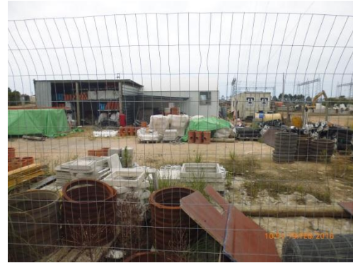
Ilustración 6 – Insumos acopiados en el obrador.
