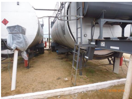
Ilustración 15 – Vista de la planta asfáltica. No se impermeabilizó el piso.
