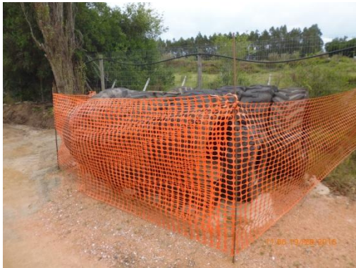
Ilustración 13 – Acopio de cubiertas.
