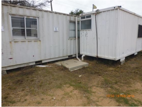
Ilustración 5 – Pozo negro al que se conectan los baños del obrador.
