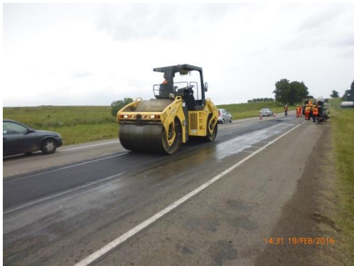
Ilustración 19 – Frente de obra.
