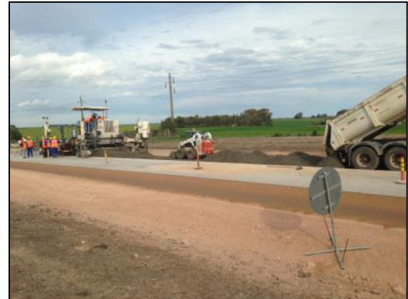
Extendido del hormigón (setiembre 2015).
