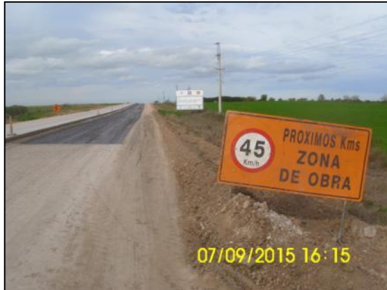
Riego de curado al inicio del tramo de obra (setiembre 2015).
