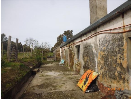
Ilustración 4 – Obrador. Restos de materiales de obra.
