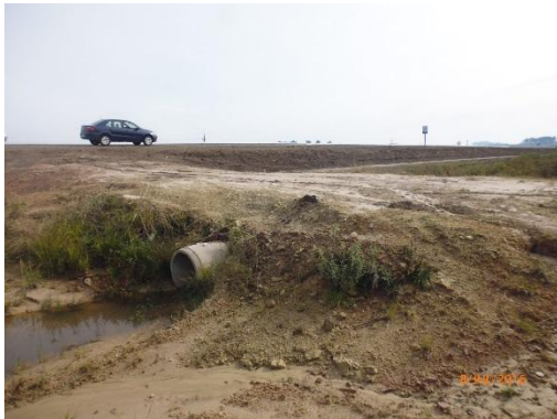
Ilustración 10 – Entrada a la zona de préstamos P06
