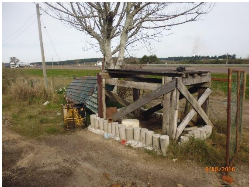
Ilustración 6 – Obrador. Se retiró el tanque de combustible.
