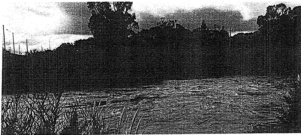
Figura 7: Margen del canal aguas abajo del puente erosionada
