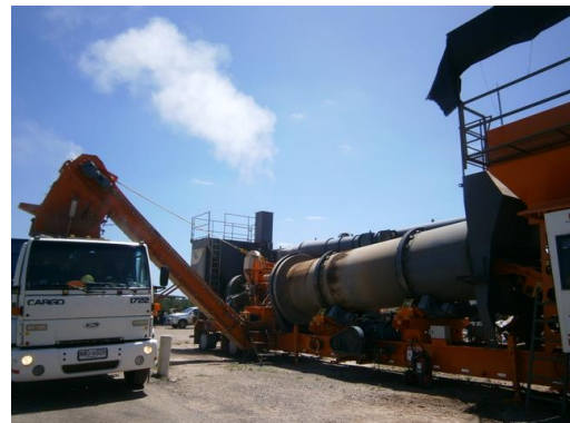
Ilustración 10 - Planta asfáltica trabajando en campamento Ruta 5, 416K500
