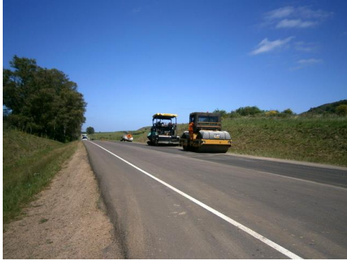
Ilustración 7 - Recapado desde progresiva 404K000
