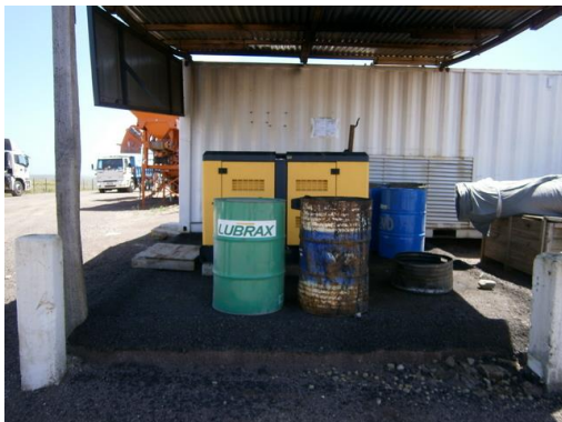
Ilustración 9 - Almacenamiento de hidrocarburos usados y generador en campamento Ruta 5, 416K500
