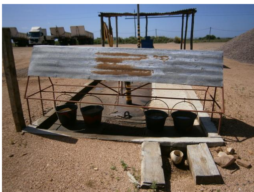
Ilustración 17-Tanque de combustible subterráneo, obrador Ruta 26, Villa Ansina
