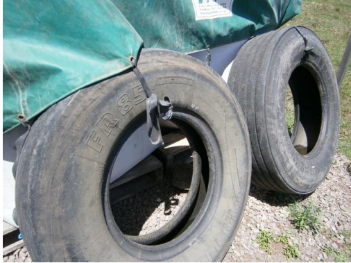
Ilustración 13-Cubiertas usadas como contrapeso para proteger materiales. Campamento Ruta 5, 416K500
