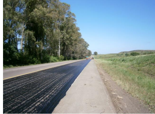
Ilustración 8 - Recapado desde progresiva 404K000
