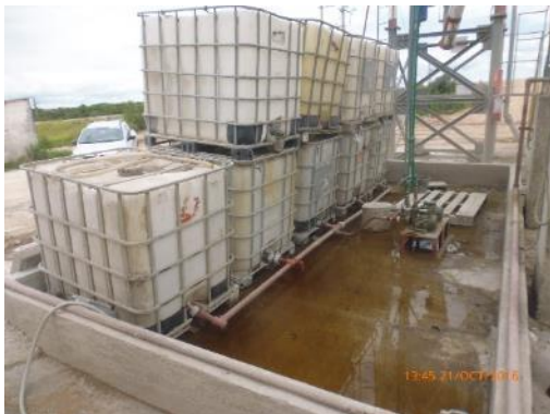
Ilustración 12 - Unidades de planta de hormigón en desmantelamiento.
