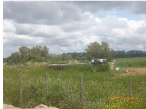
Ilustración 25 - Nuevo campamento: tanque de almacenamiento de agua. Fuente de agua subterránea
