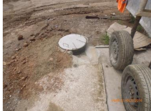
Ilustración 5 - Depósito fijo impermeable con rejilla.
