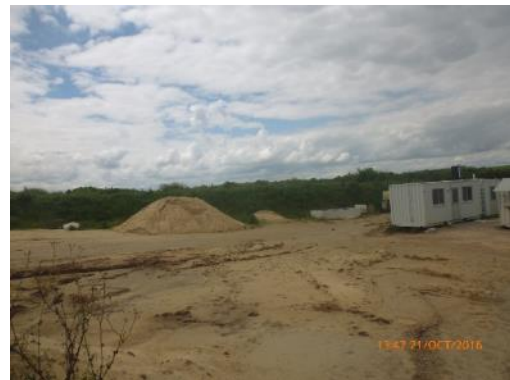
Ilustración 13 - Zona a remediar, al fondo terraplenes de suelo orgánico a restituir.
