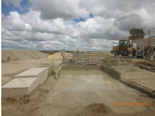
Ilustración 22 - Nuevo campamento: al fondo zona de acopio de material granular
