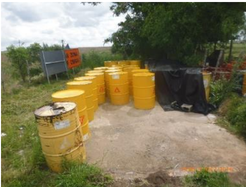
Ilustración 6 - Tanques con productos químicos (antisol blanco) en zona sin contención perimetral en el obrador.
