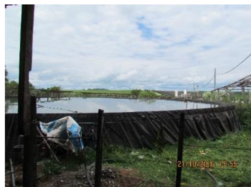
Ilustración 15 - Tanque australiano abastecido con agua subterránea para planta de hormigón. A desmantelar.
