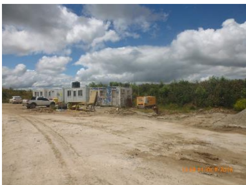
Ilustración 20 - Nuevo campamento: al fondo material orgánico conformado en taludes empastados
