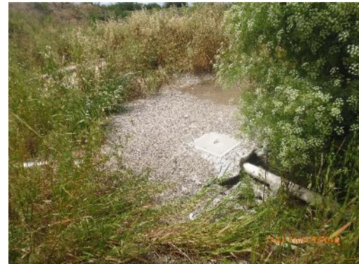
Ilustración 19 - Nuevo campamento: colector de baños hacia depósito fijo impermeable
