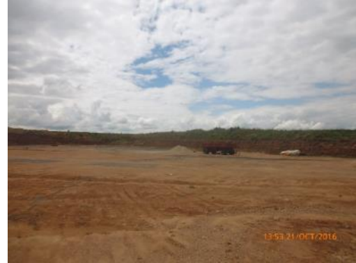
Ilustración 17: Cantera de material granular, padrón N° 15.883) cerrada.
