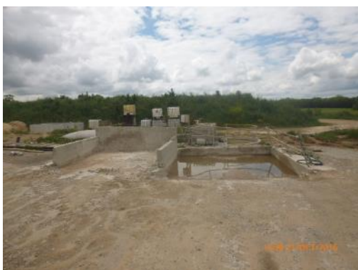
Ilustración 14 - Unidades de planta de hormigón en desmantelamiento.
