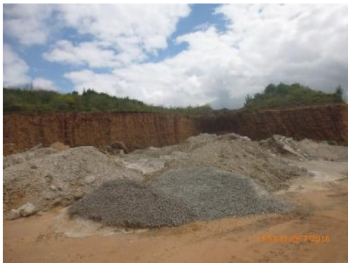
Ilustración 18 - Disposición final de material sobrante de elaboración de hormigón, en cantera.
