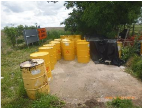
Ilustración 6 - Tanques con productos químicos (antisol blanco) en zona sin contención perimetral en el obrador.
