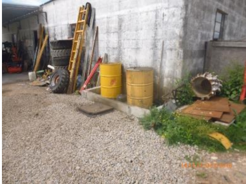
Ilustración 10 – Tanques de aceite usado en zona de contención y cámara de separación.
