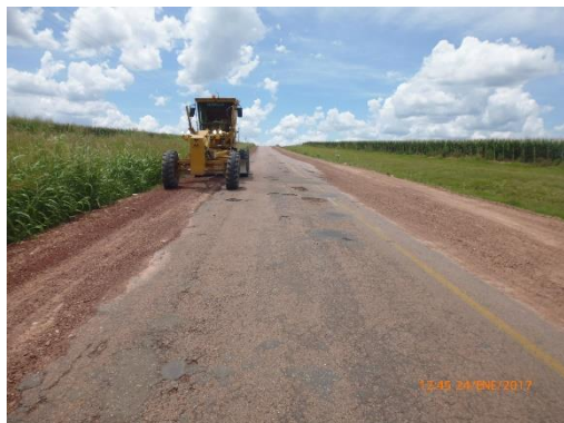
Ilustración 17 - Motoniveladora en frente de obra
