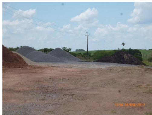
Ilustración 18 - Acopio de material granular en faja pública
