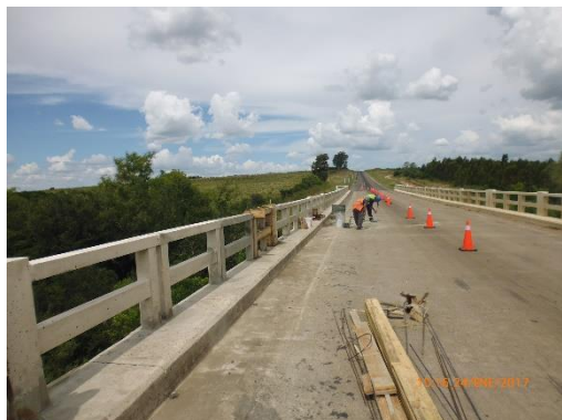
Ilustración 23 - P09. Río San Juan. Reparaciones en puente.
