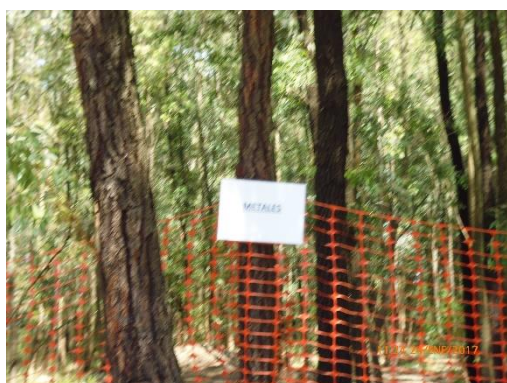
Ilustración 13 - P07. Obrador. Limitación del predio del obrador
