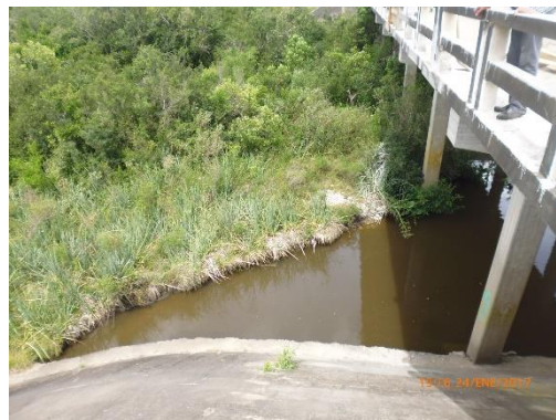
Ilustración 24 - P09. Río San Juan. Zona a rellenar en pie de talud de hormigón.
