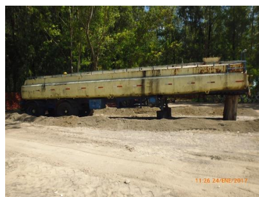
Ilustración 16 - P07. Obrador. Cisterna para almacenamiento de mezcla asfáltica. Terraplen perimetral de contención de derrames.
