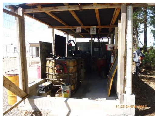
Ilustración 10 - P07. Obrador. Caseta de contención
