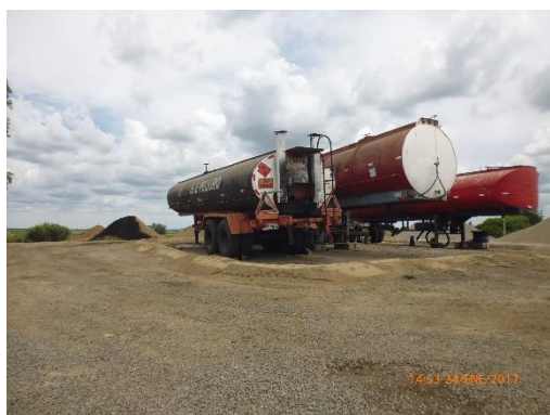
Ilustración 19 - P08. Campamento. Tanques para mezcla asfáltica. Terraplen de contención por derrames.
