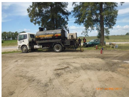
Ilustración 21 - P08. Campamento. Camión regador de asfalto.
