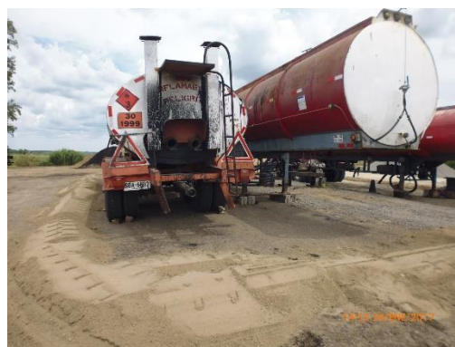
Ilustración 20 - P08. Campamento. Tanques para mezcla asfáltica. Terraplen de contención por derrames.
