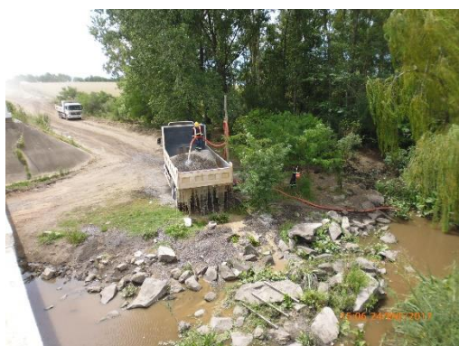
Ilustración 25 - P09. Río San Juan. Vertido en curso de agua. Lavado de material granular.
