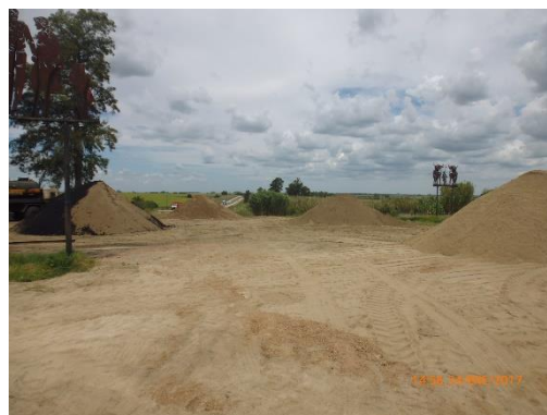
Ilustración 22 - P08. Campamento. Acopio de material granular y mezcla asfáltica.
