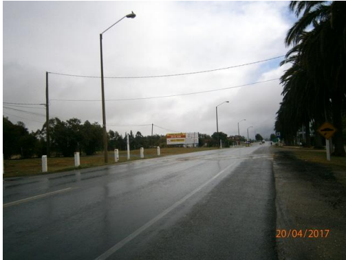
Ilustración 4 - Frente de obra, Picada Varela
