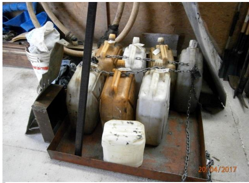
Ilustración 6 - Bandeja para contención de hidrocarburos
