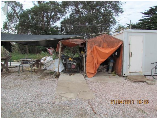
Ilustración 12 - Carpas para resguardo de herramientas electromecánicas y bolsones con residuos de madera
