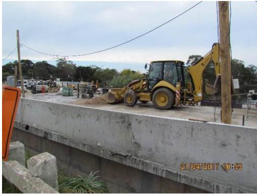
Ilustración 18 - Frente de obra sobre puente nuevo
