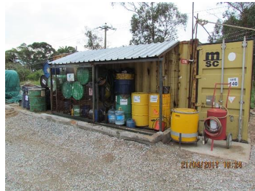
Ilustración 9 - Sitio de acopio de productos químicos, combustibles, baterías, filtros y líquidos lubricantes
