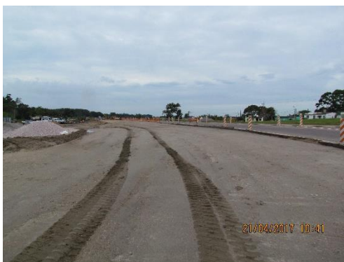
Ilustración 16 - Explanada para nueva traza de ruta. Acceso norte.
