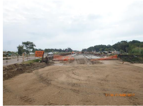
Ilustración 19 - Acceso sur al puente nuevo Frente de obra en puente nuevo
