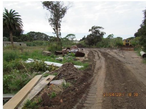
Ilustración 15 - Zona de acopio de materiales varios y estacionamiento de maquinaria
