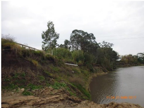
Ilustración 20 - Tubería de vertido de líquidos de pileta de lavado en el canal Ataguías en margen sur
