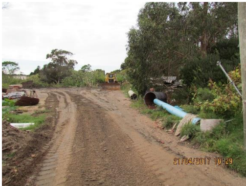
Ilustración 8 - Zona de acopio de materiales varios y estacionamiento de maquinaria
