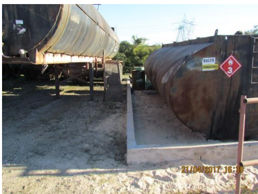
Ilustración 16 – Tanques de fuel oil sin impermeabilización
