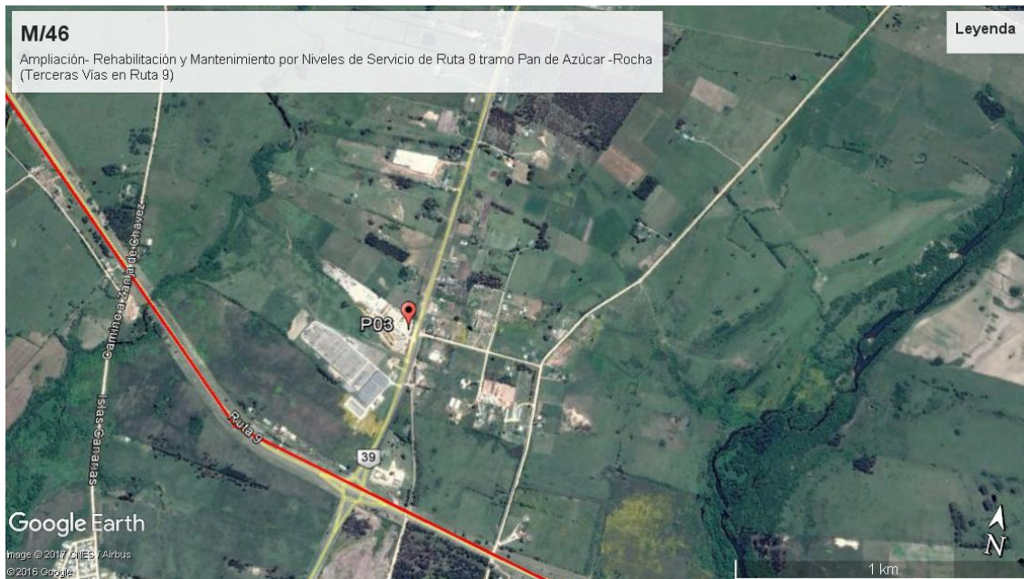
Ilustración 4 - Predio afectado por el obrador y planta asfáltica (P03) y su cercanía a la Ruta 9.
