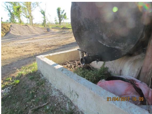
Ilustración 14 – Acopio de asfalto sin impermeabilización
