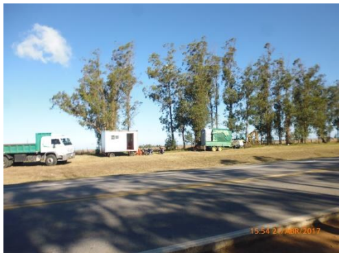
Ilustración 8 – Campamento en frente de obra
