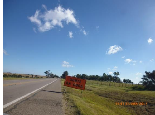
Ilustración 7 – Cartelería en frente de obra
