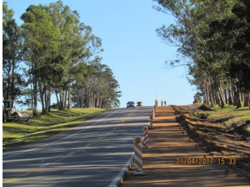
Ilustración 6 – Frente de obra
