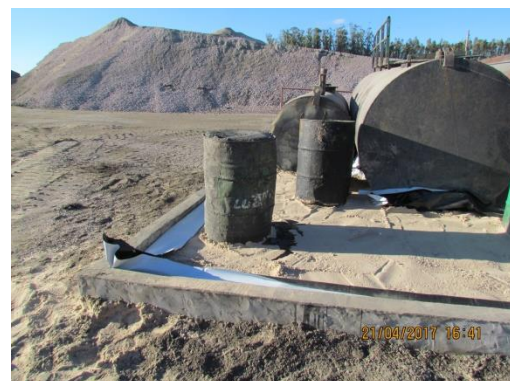
Ilustración 17 – Piso con impermeabilización
