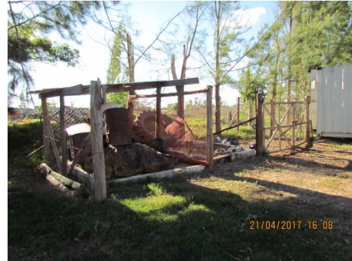
Ilustración 13 – Depósito de productos peligrosos sin impermeabilización
