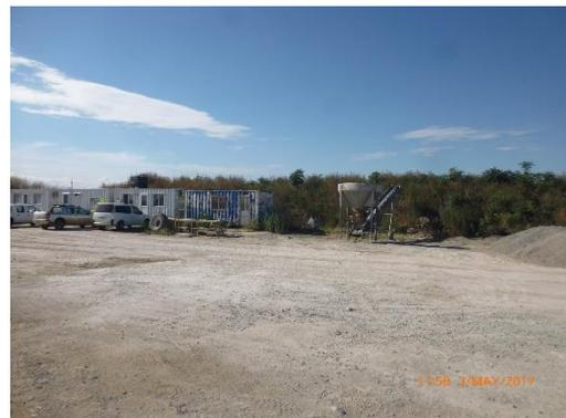
Ilustración 20 - Planta de hormigón. Oficinas al frente. Terraplenes de material orgánico al fondo.
