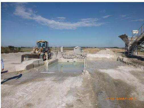
Ilustración 21 - Planta de hormigón. Pileta de lavado de camiones y sistema de reciclado de agua.
