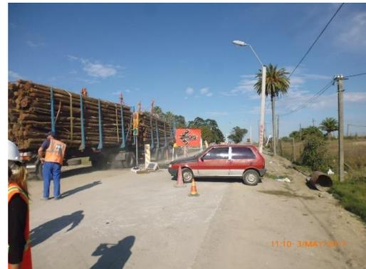
Ilustración 32 - Frente de obra. Control de tránsito en acceso sur. Control con semáforos.
