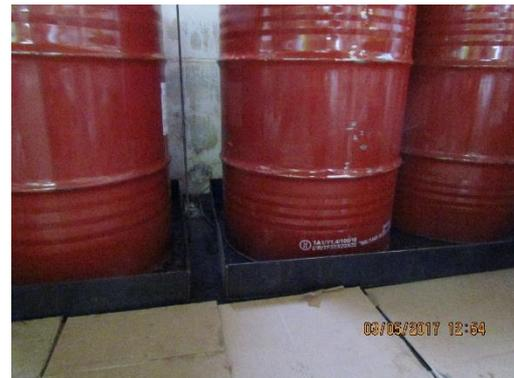
Ilustración 14 - Obrador. Tanques de lubricantes dentro del obrador sobre bandejas de contención
