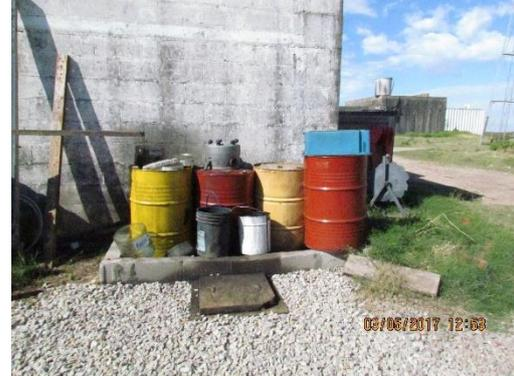
Ilustración 12 - Obrador. Tanques de aceite usado en zona de contención y cámara de separación. Pedregullo en el perímetro.
