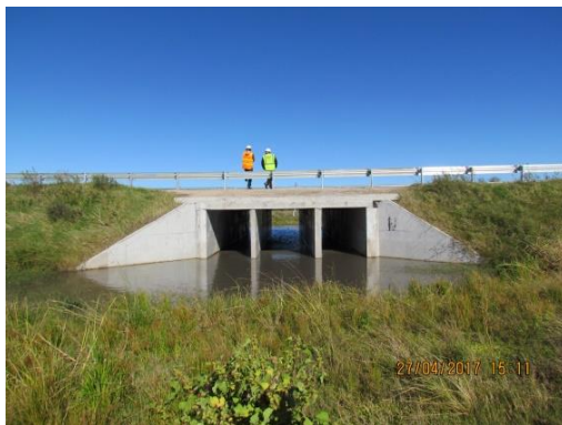
Ilustración 6 – Vista de la Alcantarilla (-)
