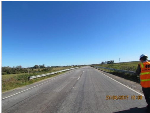
Ilustración 4 – Barras metálicas que fueron colocadas
