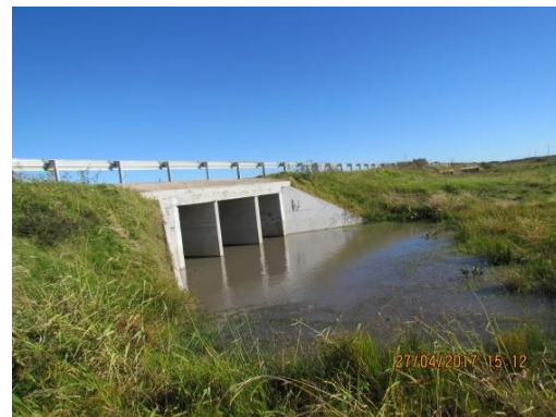
Ilustración 7 – Otra vista de la Alcantarilla (-)
