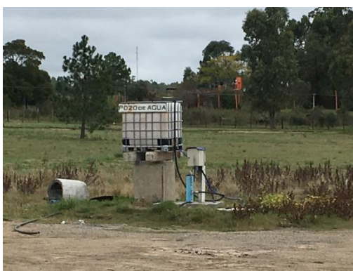
Ilustración 15 – Perforación para extracción de agua subterránea
