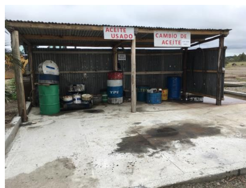
Ilustración 16 – Cercos perimetrales de depósito de aceites usados
