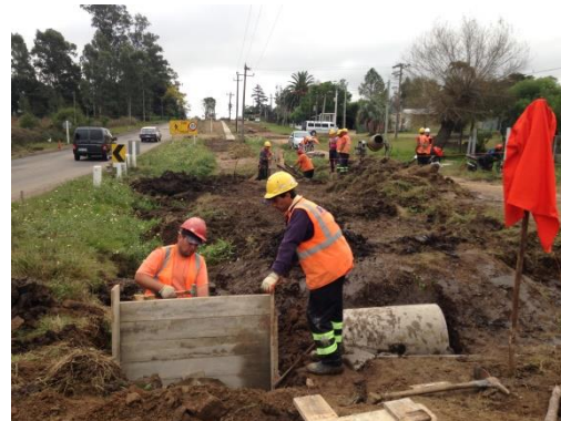
Ilustración 20 – Construcción de sendas peatonales
