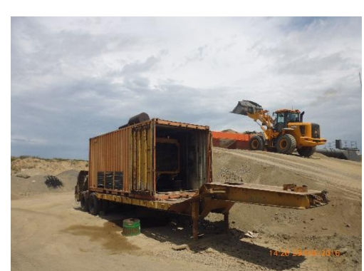
Ilustración 9 – Mancha de hidrocarburos bajo el generador de la planta asfáltica.
