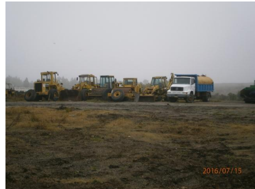
Ilustración 13-Maquinaria en mantenimiento en progresiva 58K800 obrador y canteras
