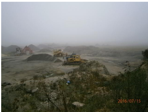
Ilustración 6-Vista de canteras y maquinaria de trituración, 58K800
