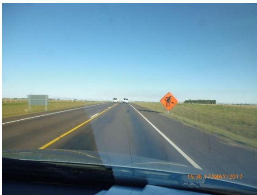
Ilustración 13 - Frente de obras. Tareas finalizadas en el tramo.
