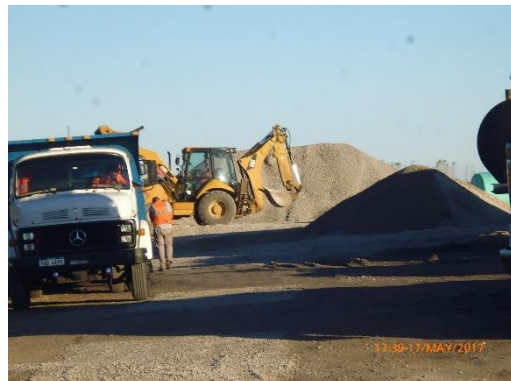
Ilustración 8 - Frente de obras. Campamento sobre Ruta 5. Carga y descarga de áridos.
