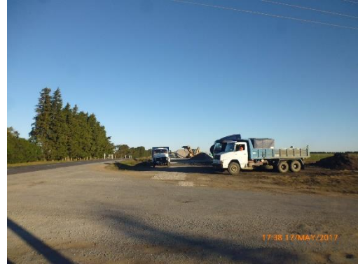
Ilustración 6 - Frente de obras. Campamento sobre Ruta 5.
