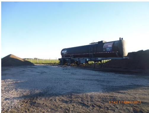
Ilustración 7 - Frente de obras. Campamento sobre Ruta 5. Tanque de asfalto.
