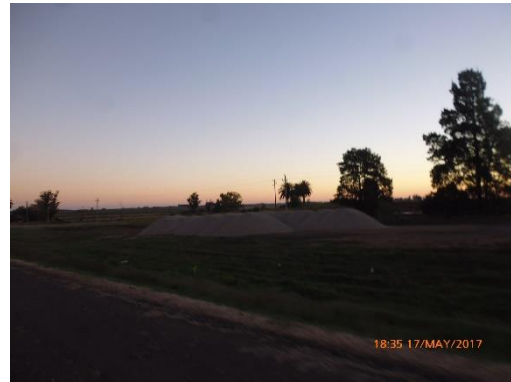
Ilustración 12 - Frente de obras. Acopio de material granular en faja pública.
