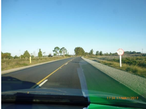
Ilustración 5 - Frente de Obras.
