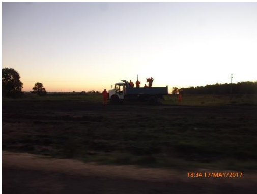
Ilustración 11 - Frente de obras. Personal de la empresa.
