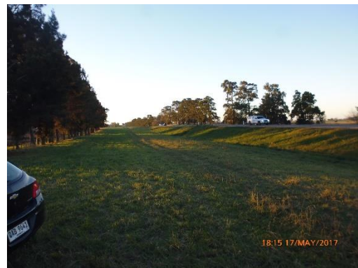
Ilustración 14 - Frente de obras. Tareas de mantenimiento de faja pública finalizadas en el tramo.
