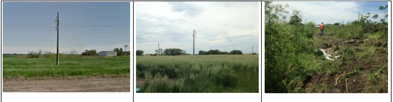
Imágenes del predio donde se ubica la segunda planta de elaboración de materiales, previo a la implantación en el km 61.
