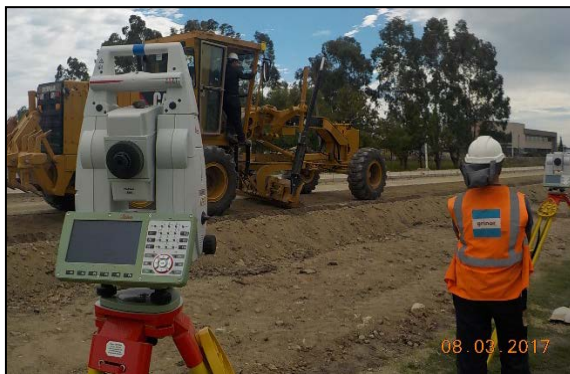
Reciclado de base con cemento. Mar '17.
