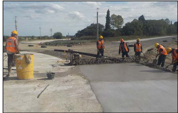
Ejecución manual en rotondas. Feb '17.
