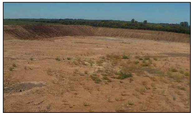
Regularización de taludes en acondicionamiento de cantera.
