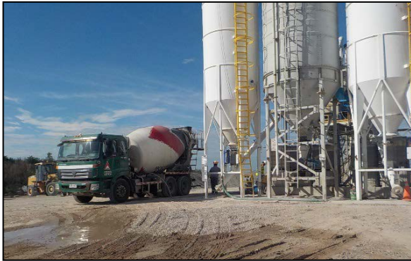
Transporte de hormigón elaborado. Feb'17
