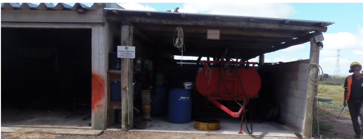
Gráfico 3-1 Acopio de combustibles en el obrador
