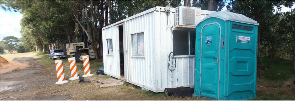
Gráfico 2-2 Trabajos realizados por cuadrilla de TECHINT
