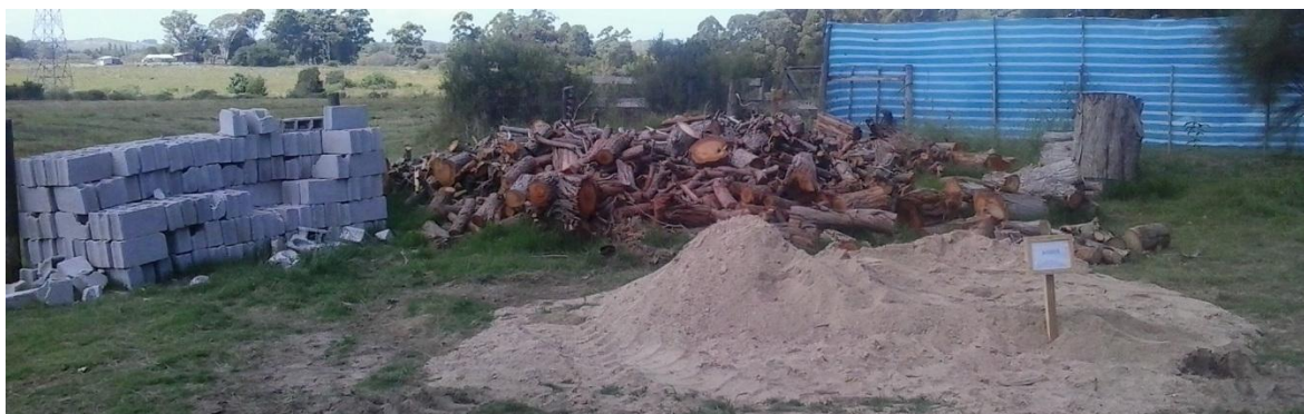
Gráfico 3-2 Acopio de áridos en obrador PIETROBONI
