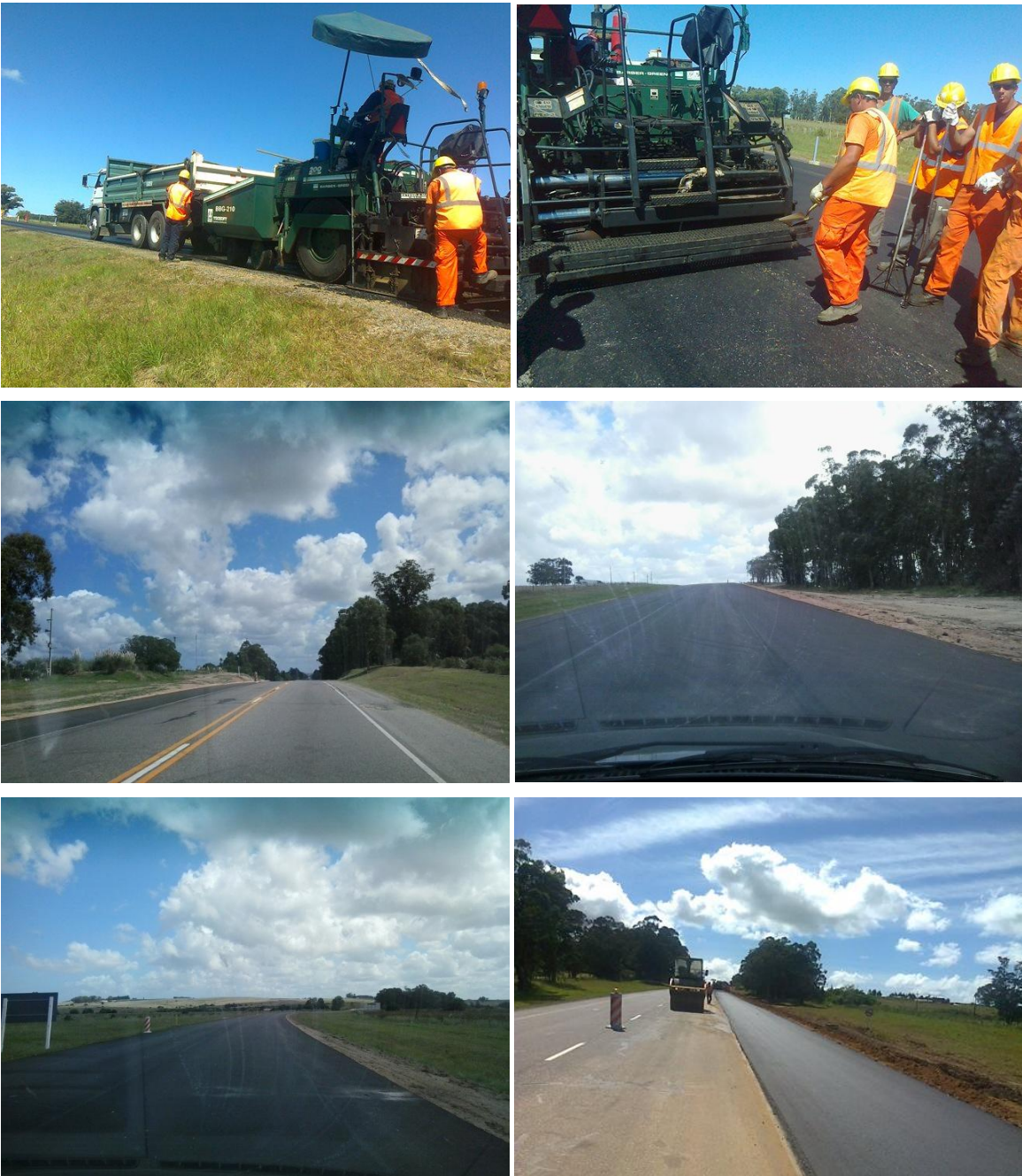
Gráfico 2-1 Trabajos realizados por cuadrilla de TECHINT
