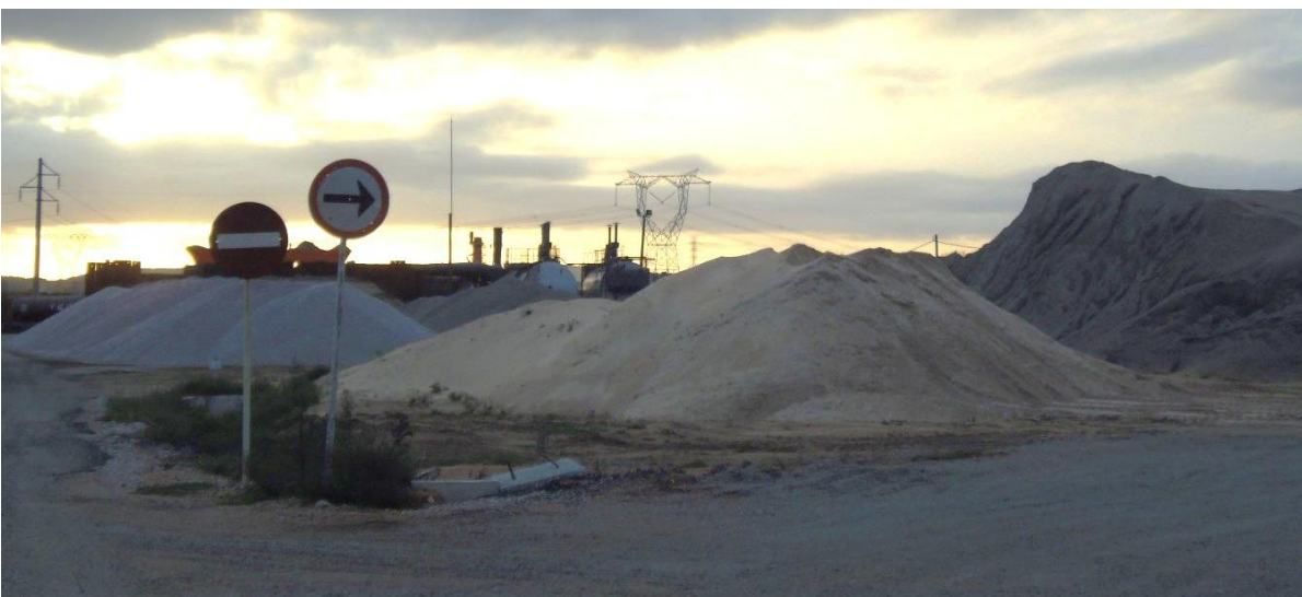
Figura 3-3 Acopio de áridos en planta de asfalto
