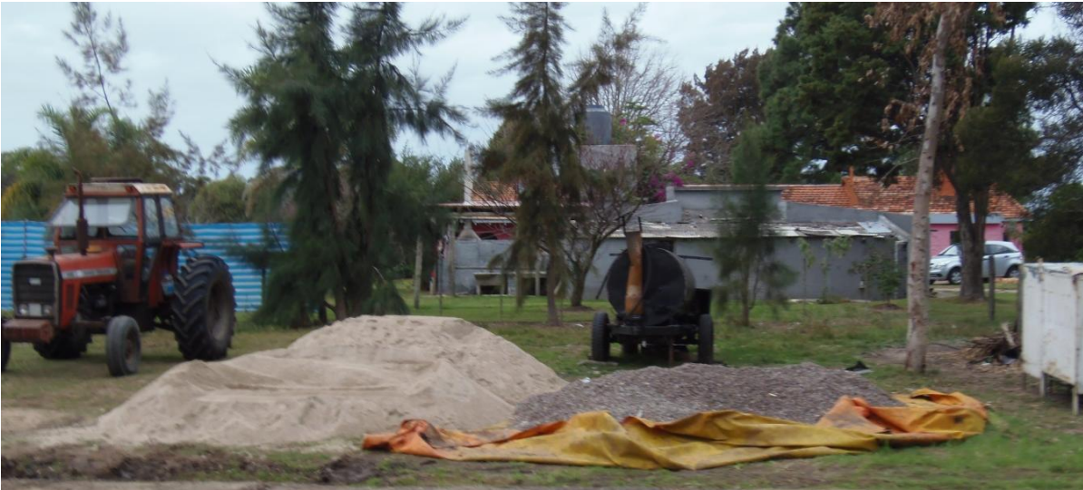
Figura 3-2 Acopio de áridos en obrador PIETROBONI
