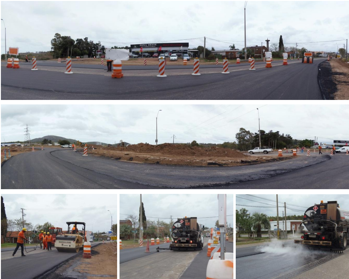
Figura 2-1 Trabajos realizados por cuadrilla de TECHINT
