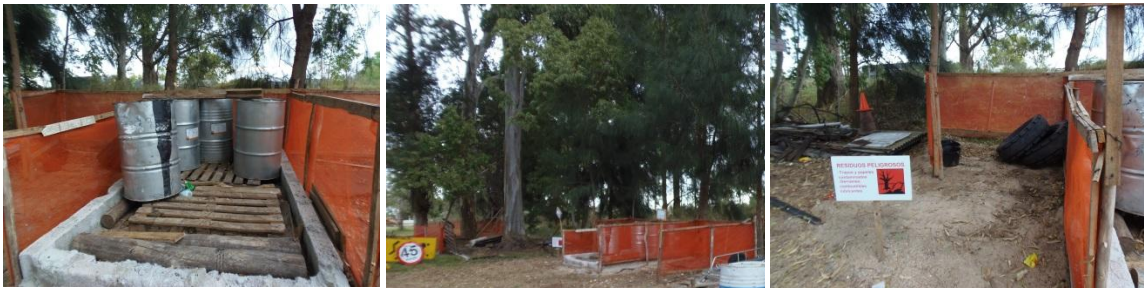
Figura 6-1 Punto de acopio transitorio de residuos
