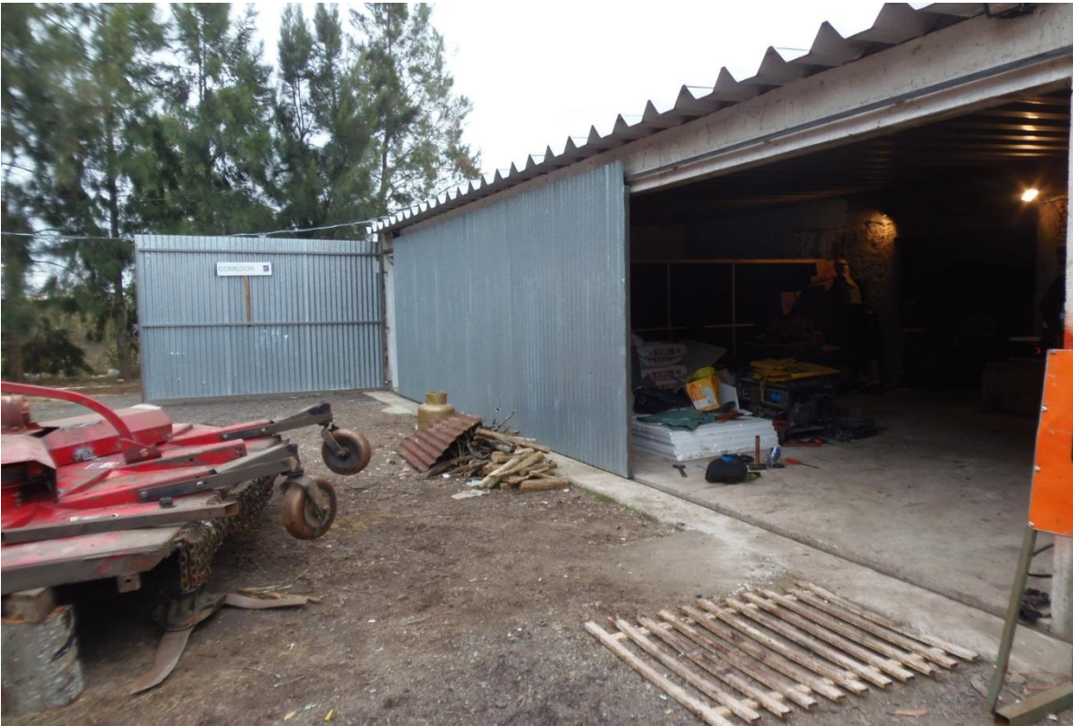
Figura 5-1 Taller de mantenimiento PIETROBONI
