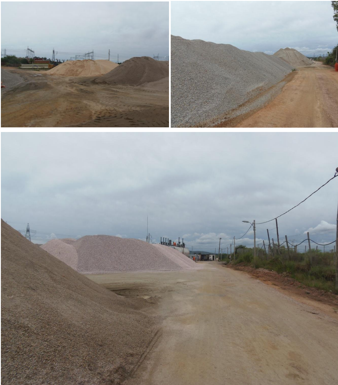
Figura 3-1 Acopio de áridos en planta de asfalto
