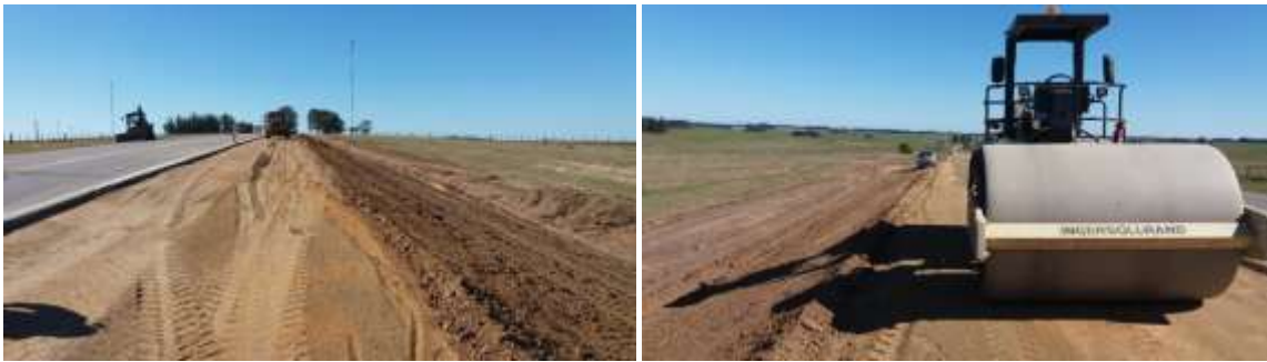
Figura 2-1 Imágenes de los trabajos realizados
