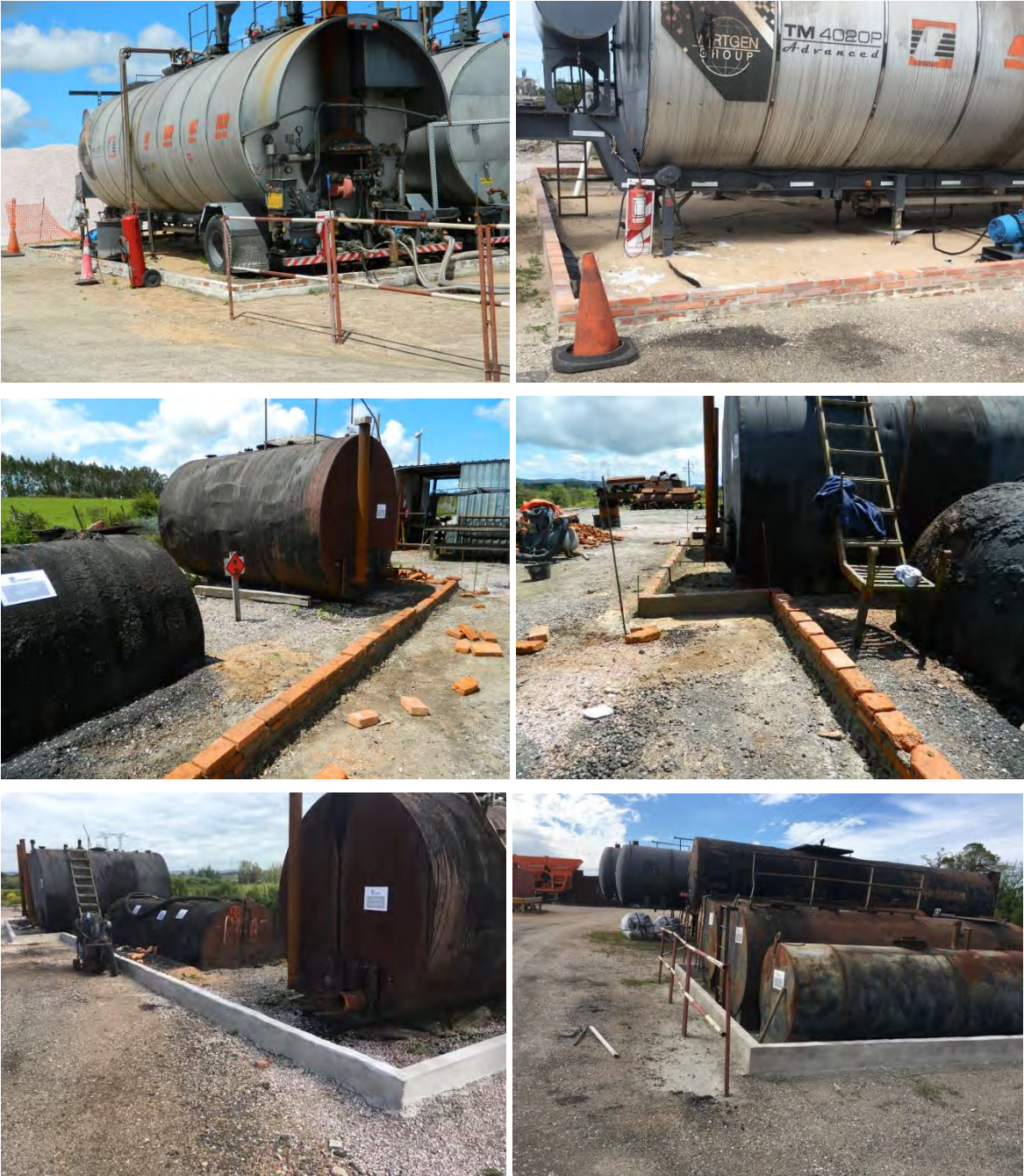
Figura 4-1 Planta y acopios de asfaltos
