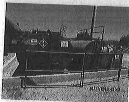
Ilustración 11 - Fueloil en cerco perimetral sin impermeabilización.
