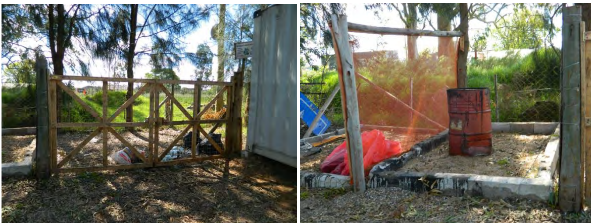
Figura 6-1 Acopio transitorio de residuos
