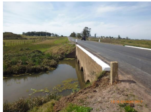
Ilustración 22 - Frente de obras. Alcantarilla.
