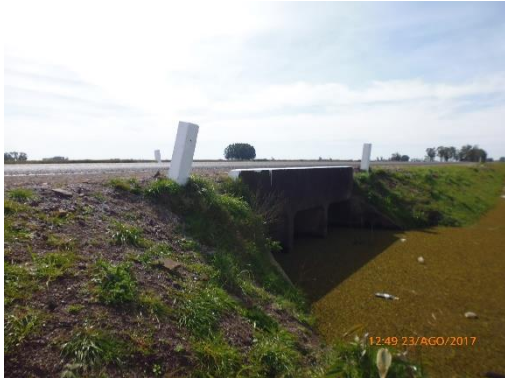
Ilustración 17 - Frente Obras. Alcantarillas finalizada.
