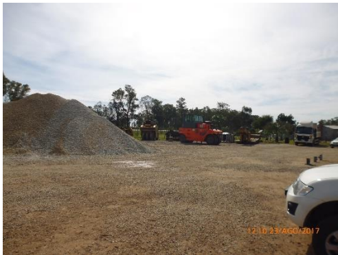
Ilustración 7 - Obrador. Acopio de piedra.
