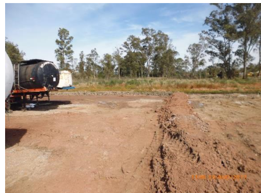
Ilustración 16 - Obrador. Dique perimetral de contención de derrames.
