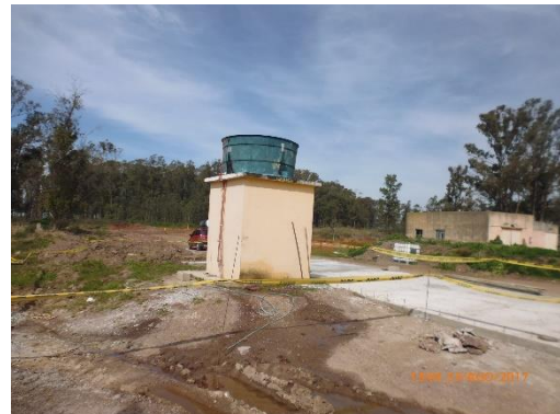
Ilustración 14 - Obrador. Tanque elevado de agua.
