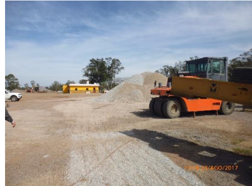
Ilustración 6 - Obrador. Acopio de piedra. Maquinaria.
