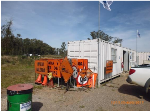
Ilustración 10 - Obrador. Acopio de cartelería. Oficinas.
