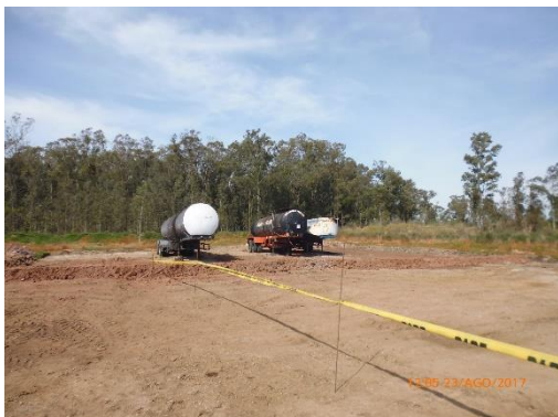
Ilustración 15 - Obrador. Acopios de diluido asfáltico.
