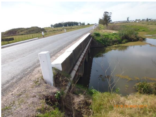
Ilustración 21 - Frente de obras. Alcantarilla.
