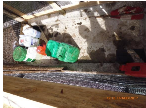
Ilustración 12 - Obrador. Losa en acopio de residuos especiales.
