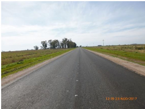
Ilustración 19 - Frente Obras. Ruta 15. Señalización horizontal pendiente.
