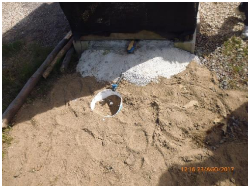
Ilustración 13 - Obrador. Dispositivo recolección de derrames.
