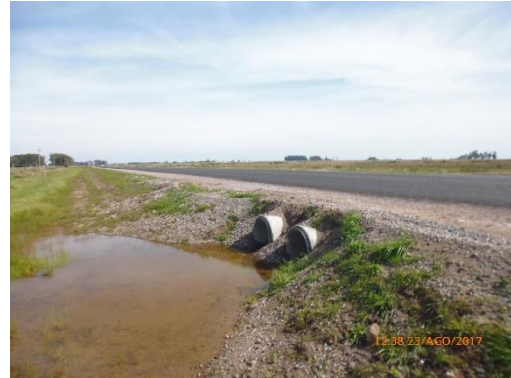
Ilustración 18 - Frente Obras. Alcantarilla en ejecución, cabezales pendientes.
