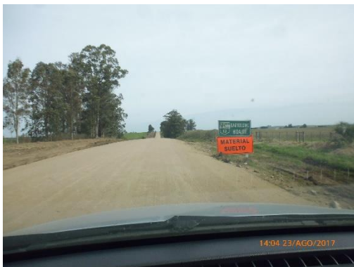
Ilustración 16 - Frente de obra.
