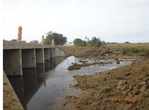
Ilustración 21 - Frente Obras. Alcantarilla P09.
