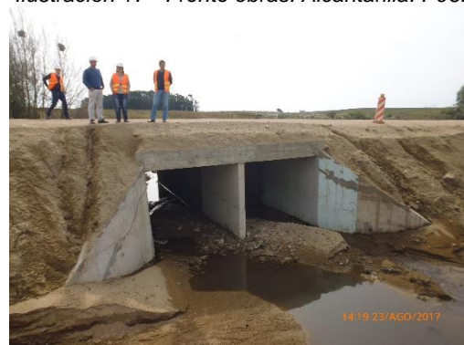
Ilustración 19 - Frente Obras. Alcantarilla. P07.
