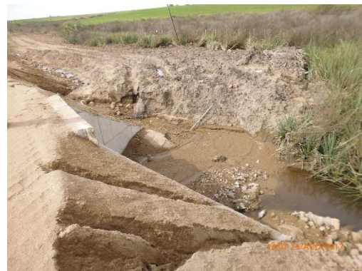
Ilustración 17 - Frente obras. Alcantarilla. P06.
