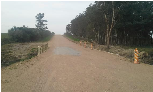
Ilustración 26 - Frente Obras. Alcantarilla señalizada.
