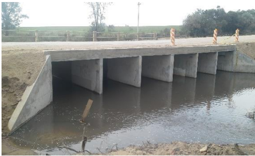
Ilustración 22 - Frente Obras. Alcantarilla. P10.
