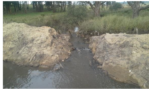
Ilustración 23 - Frente Obras. Alcantarilla. P10.
