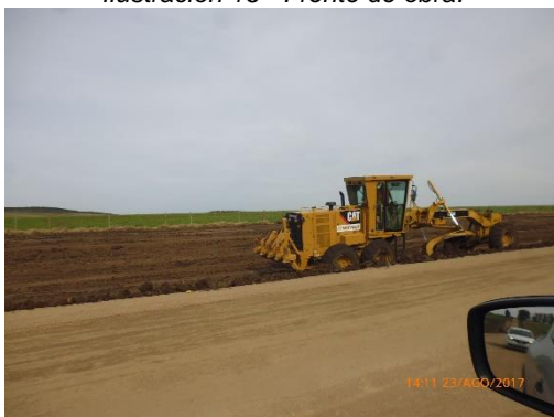
Ilustración 18 - Frente Obras. Calzado con motoniveladora.
