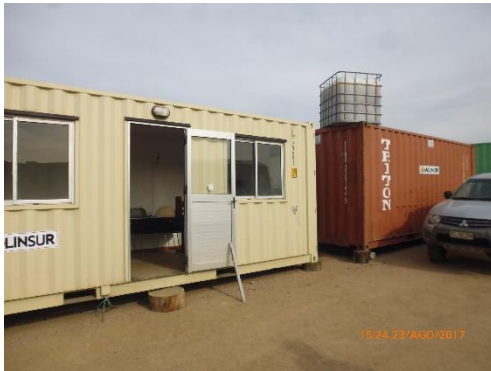
Ilustración 6 - Obrador. Oficinas y depósito.
