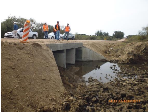
Ilustración 20 - Frente Obras. Alcantarilla. P08.
