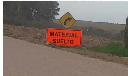
Ilustración 27 - Frente Obras. Señalización.
