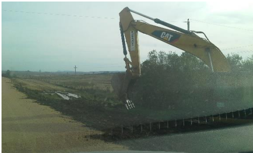
Ilustración 24 - Frente Obras. Limpieza de faja con Retroexcavadora.
