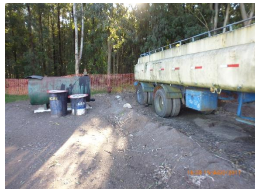
Ilustración 10 - P07. Obrador. Tanques de vacíos de diluido asfáltico.
