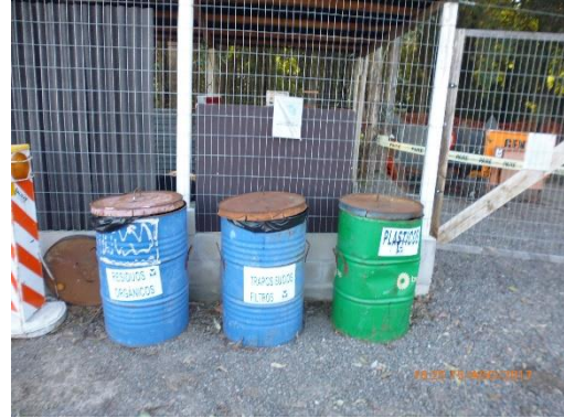
Ilustración 6 - Obrador. Tanques de contención para residuos peligrosos. Jaula con contención de hormigón.
