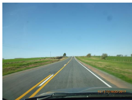
Ilustración 16 - Frente de obras.
