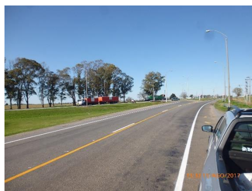
Ilustración 14 - Frente de obras.
