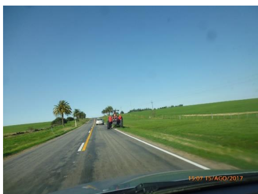
Ilustración 13 - Frente de obras. Tareas de mantenimiento.
