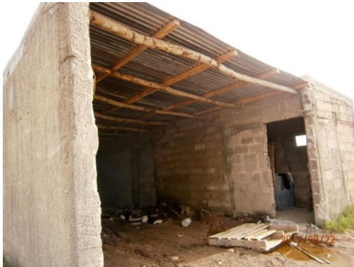
Ilustración 5 – Depósito abandonado que se encontraba en el predio del obrador inicialmente
