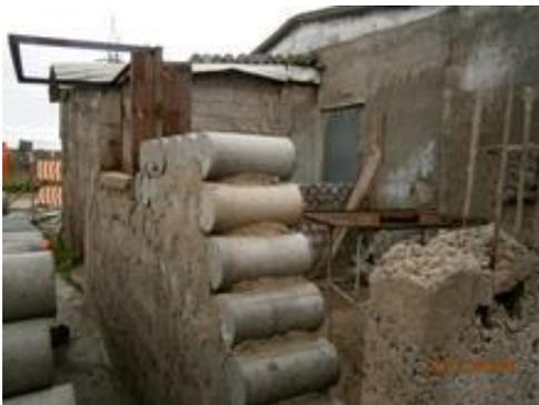
Ilustración 12 – Aprovechamiento de probetas de hormigón para construcción de un baño
