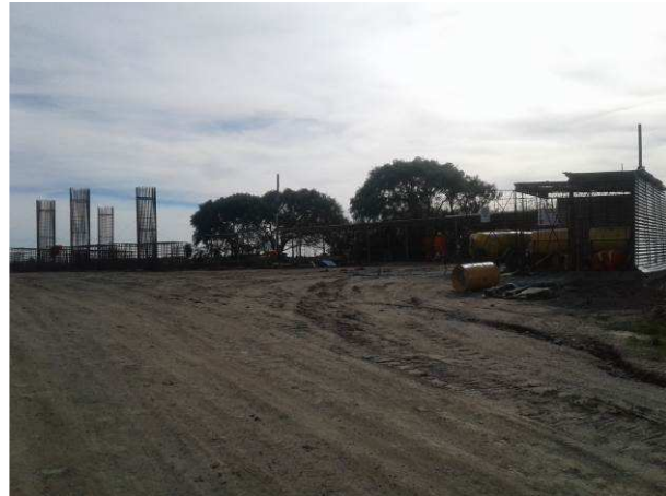
Imagen 1 – Vista obrador principal
