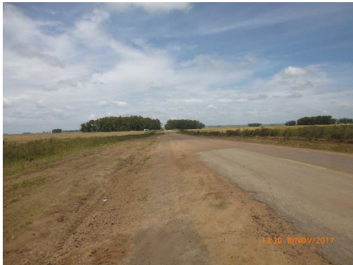
Ilustración 11 - Frente de obras. Límites del bacheo en el tramo del contrato.
