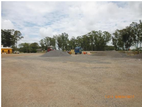
Ilustración 7 - Obrador. Acopio de piedra.
