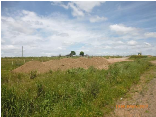
Ilustración 13 - Frente de obras. Sitio de acopios en la faja.
