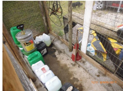
Ilustración 6 - Obrador. Recinto para residuos peligrosos.
