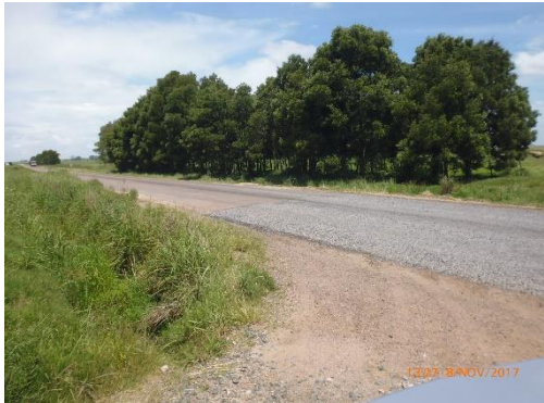
Ilustración 10 - Frente de obras. Límites del bacheo en el tramo del contrato.
