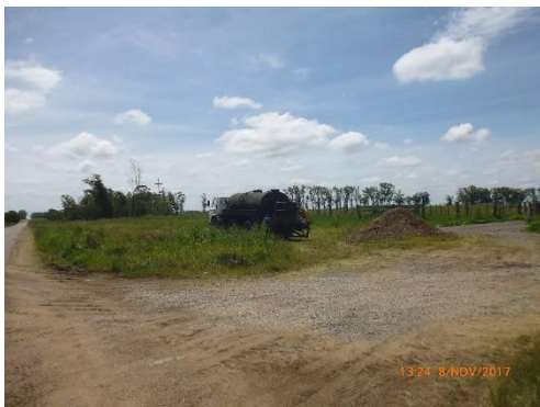
Ilustración 9 - Frente de obras. Camión regador para tratamiento bituminoso en faja.
