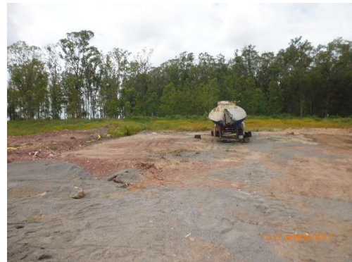
Ilustración 8 - Obrador. Zona de tanques de diluido asfáltico. Tanque vacío.
