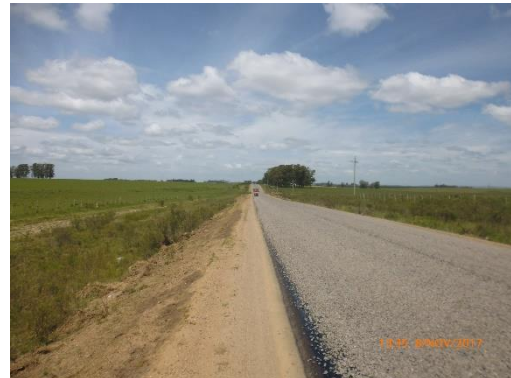
Ilustración 12 - Frente de obras. Tramo del contrato.
