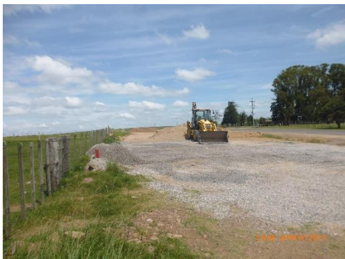
Ilustración 15 - Frente de obras. Sitio de acopios en la faja.
