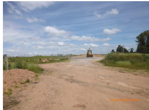
Ilustración 14 - Frente de obras. Sitio de acopios en la faja.
