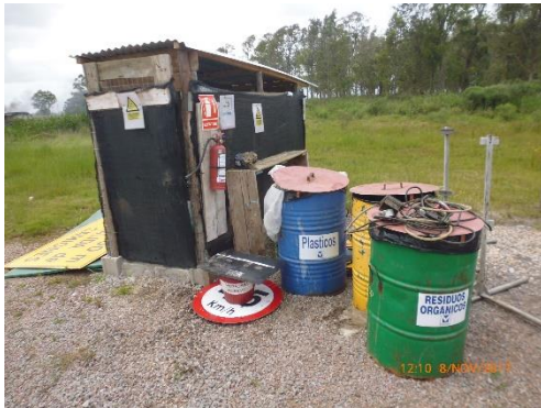
Ilustración 5 - Obrador. Tanques de residuos y recinto para residuos peligrosos.
