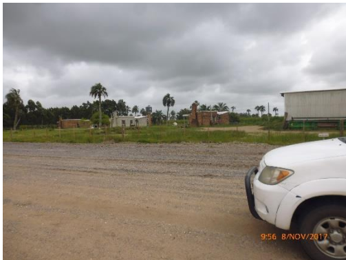
Ilustración 25 - Frente de obras. Faja acondicionada y cedida a la DNV.
