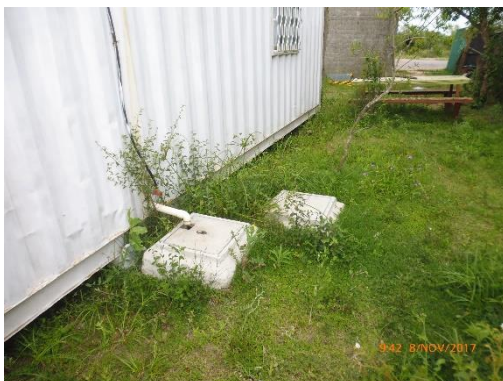
Ilustración 19 - Obrador. Cámara hacia depósito fijo impermeable.
