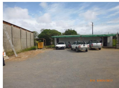
Ilustración 8 - Obrador. Izquierda: taller. Frente: oficinas.
