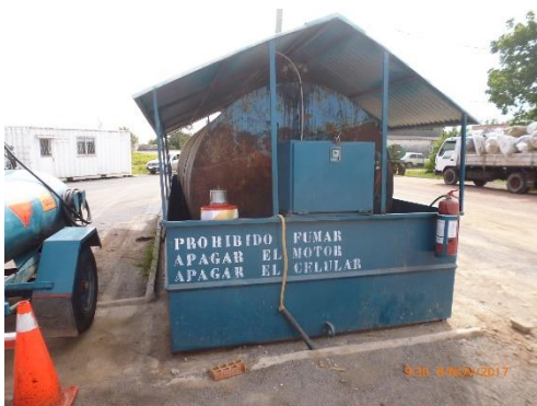
Ilustración 7 - Obrador. Depósito de gasoil.
