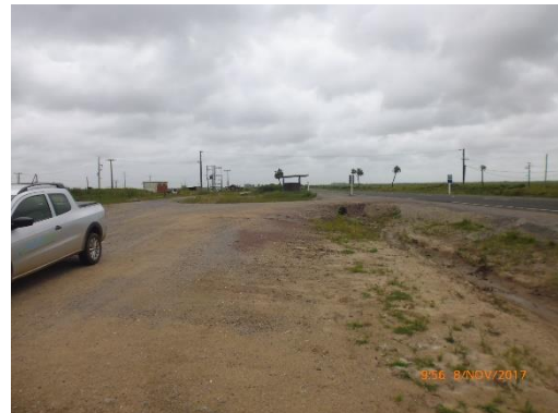
Ilustración 24 - Frente de obras. Faja acondicionada y cedida a la DNV.
