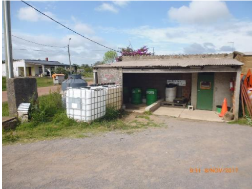
Ilustración 9 - Obrador. Pañol y recinto para baterías, repuestos, aceites y lubricantes.
