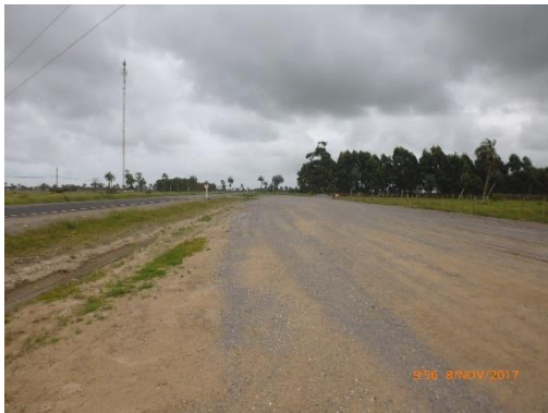
Ilustración 23 - Frente de obras. Faja acondicionada y cedida a la DNV.
