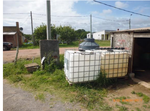
Ilustración 10 - Obrador. Tanques para traslado de agua.
