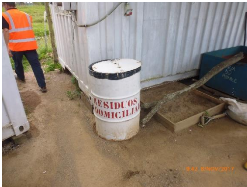
Ilustración 17 - Obrador. Depósito para residuos domiciliarios.
