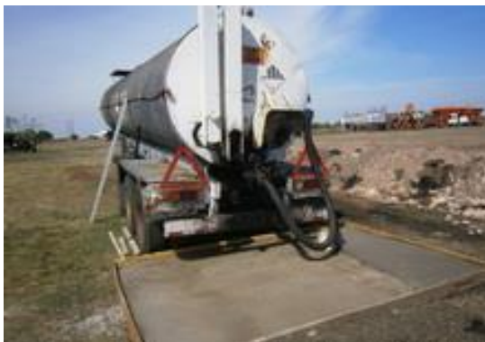
Ilustración 8 - Obrero. Zona de carga y descarga de emulsión asfáltica en construcción.
