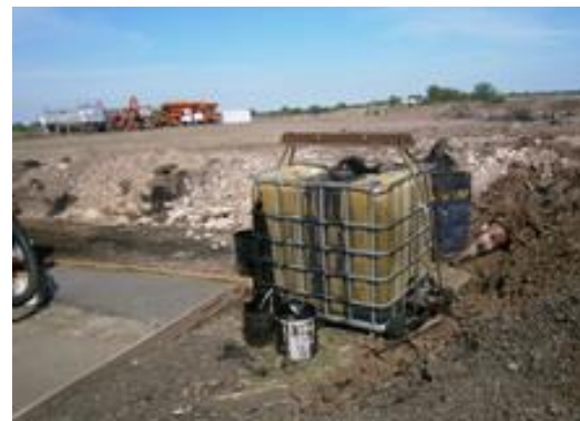
Ilustración 9 - Obrero. Zona de carga y descarga de emulsión asfáltica en construcción.
