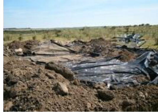
Ilustración 11 - Obrador. Zona de almacenamiento de material contaminado o con restos de hidrocarburos
