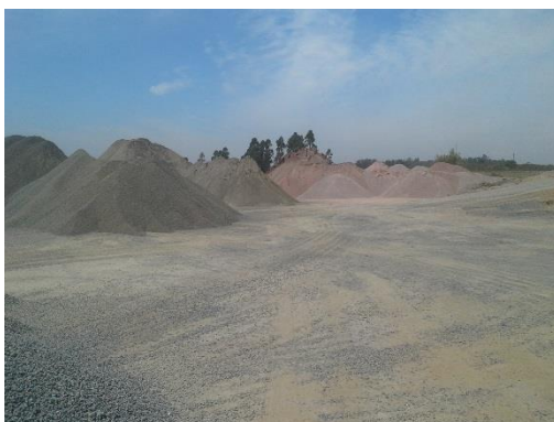
Ilustración 19 - Obrador. Acopio de áridos.
