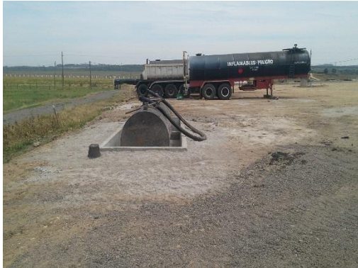
Ilustración 9 - Obrador. Depósito de emulsión asfáltica y contención de hormigón.
