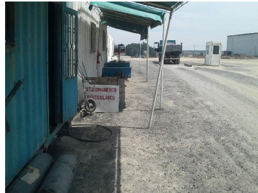
Ilustración 16 - Obrador. Laboratorio de calidad de materiales.
