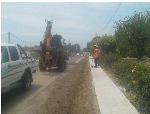
Ilustración 25 - Frente de obras. Ruta 74.
