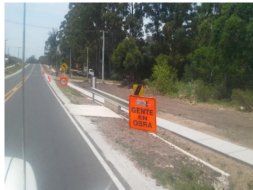
Ilustración 24 - Frente de obras. Ruta 74.
