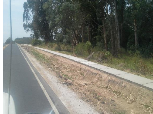
Ilustración 28 - Frente de obras. Ruta 74.
