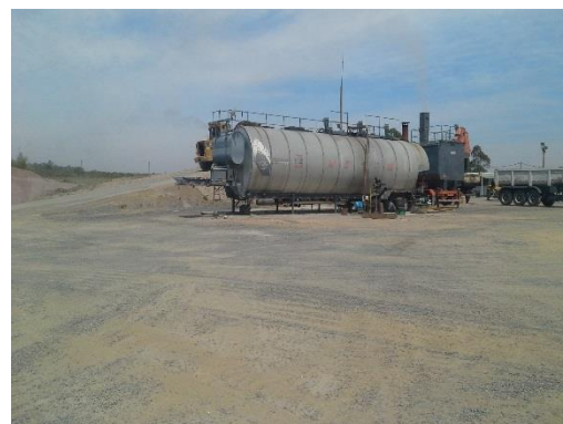
Ilustración 20 - Obrador. Planta asfáltica.
