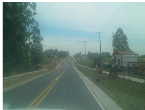
Ilustración 26 - Frente de obras. Ruta 74.
