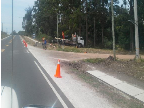
Ilustración 27 - Frente de obras. Ruta 74.
