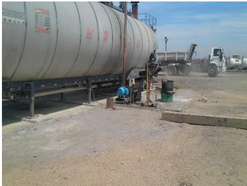
Ilustración 21 - Planta asfáltica. Base y diques perimetrales de hormigón.
