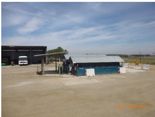
Ilustración 5 - Obrador. Depósitos de combustible.
