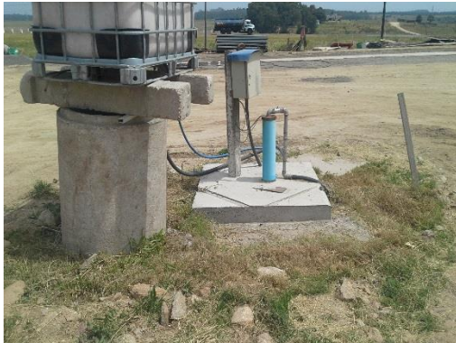
Ilustración 11 - Perforación para uso de agua subterránea.
