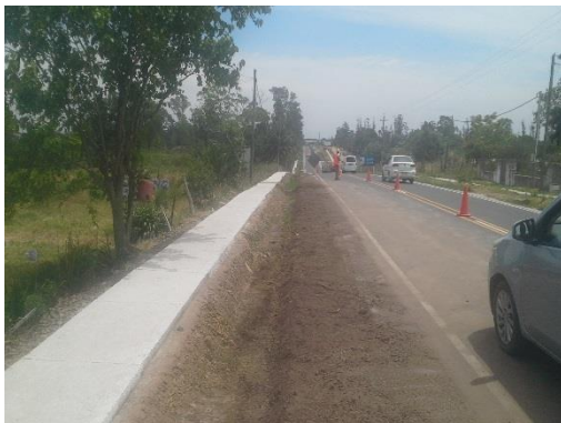
Ilustración 23 - Frente de obras. Ruta 74.
