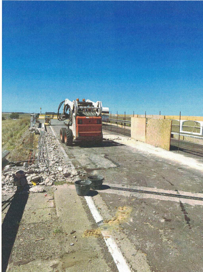
Imagen 3 – Vista tareas demolición
