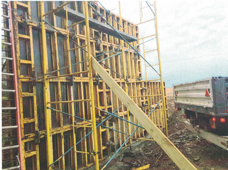
Imagen 6 – Vista tareas encofrado y armado de hierro en muros
