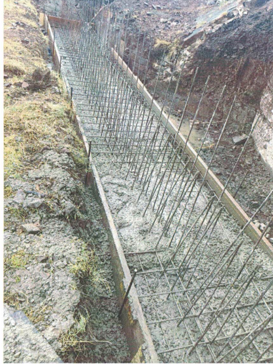
Imagen 5 – Vista tareas encofrado y armado de hierro en zapata
