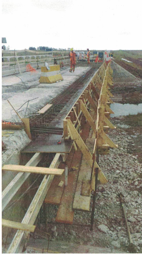
Imagen 4 – Vista tareas encofrado y armado de hierro
